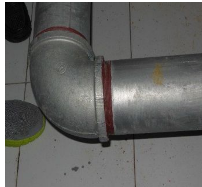
良好：外露螺纹防锈处理
