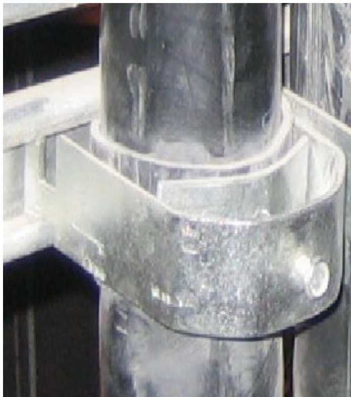
固定电缆开口金属卡具 更能保证固定耐久性
