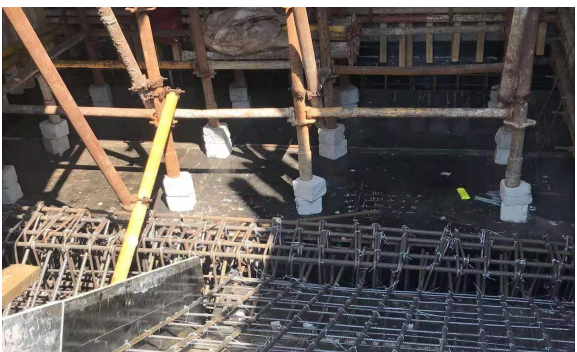
楼梯间立杆使用预制垫块
