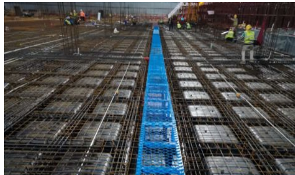
板面铺设过道
