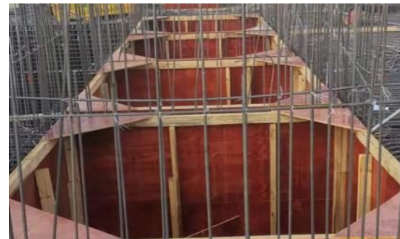
采用三角模板加固
