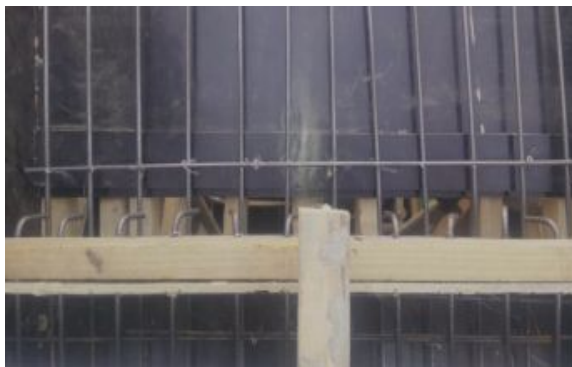
楼梯梯段施工缝位置设置
