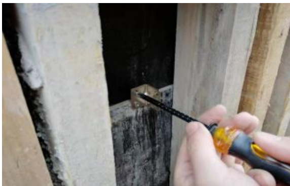
模板拼缝处使用角码固定
