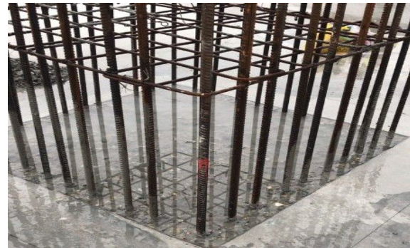
云石机边线切割后凿毛
