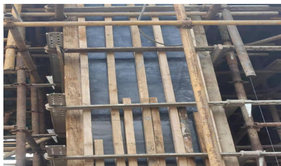
柱加固采用快易加固件
