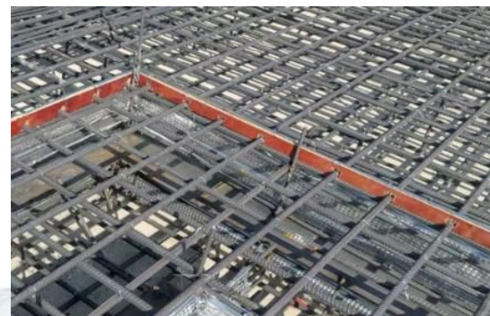
后浇带锯齿挡板控制标高
