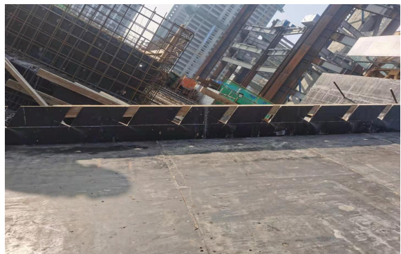
楼梯侧模开槽
