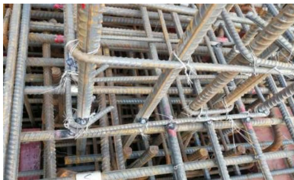
定位箍筋与板面钢筋点焊
