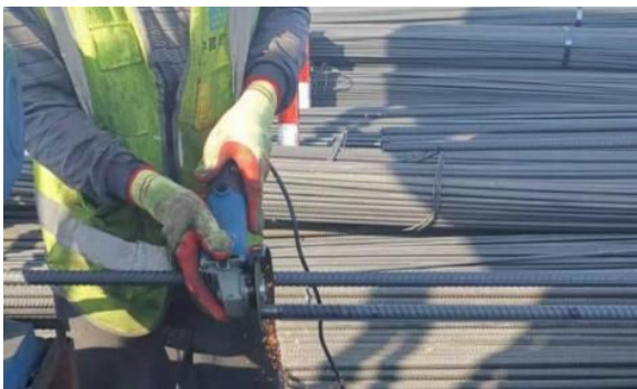
直螺纹钢筋打磨
