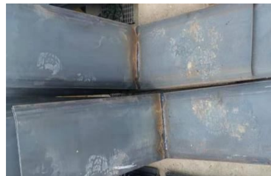
转角处止水钢板预制后安装
