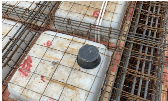
采用成品套管预留洞装置
