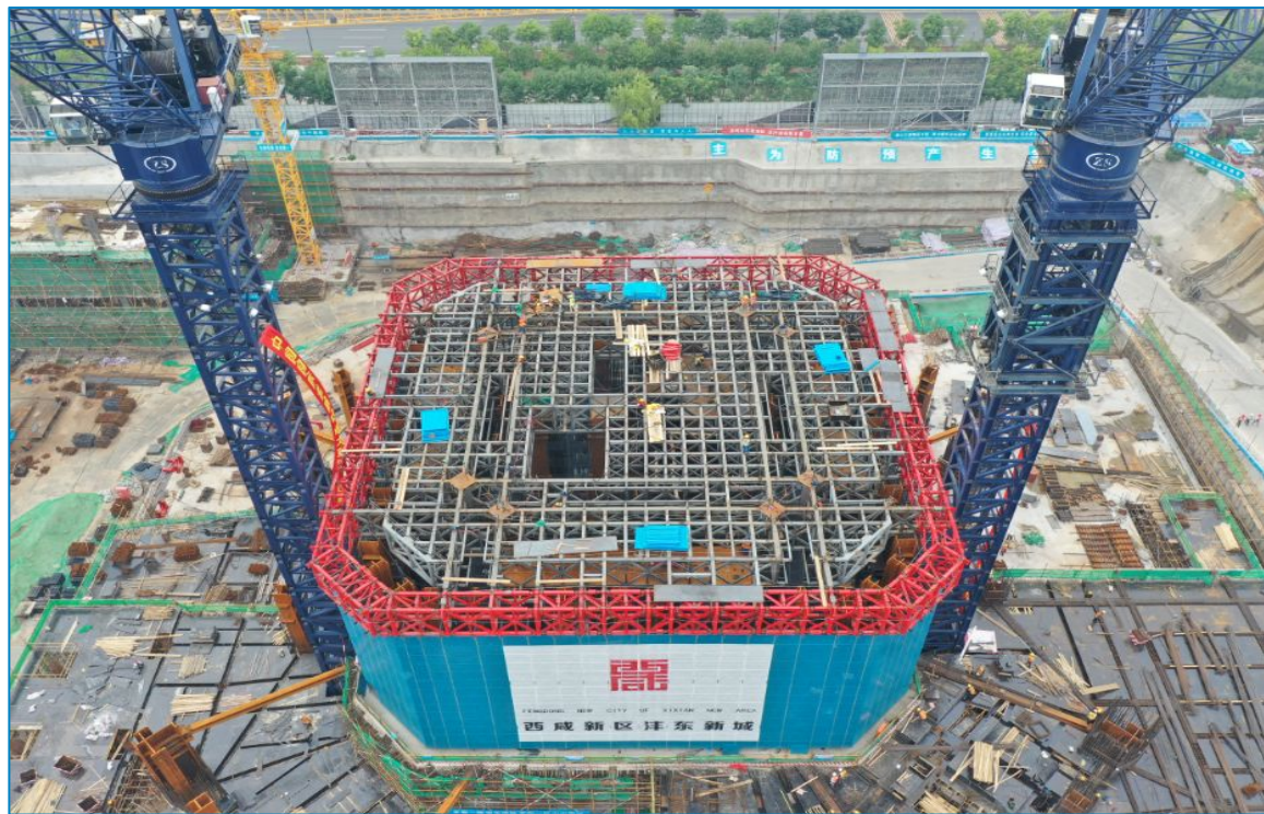
装配式钢桁架系统
