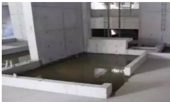
砼反坎浇筑一次性成型
