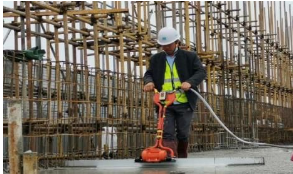
混凝土振平器
