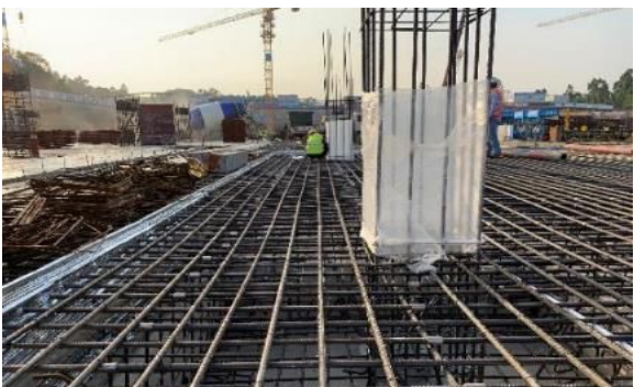
墙柱插筋包裹薄膜保护
