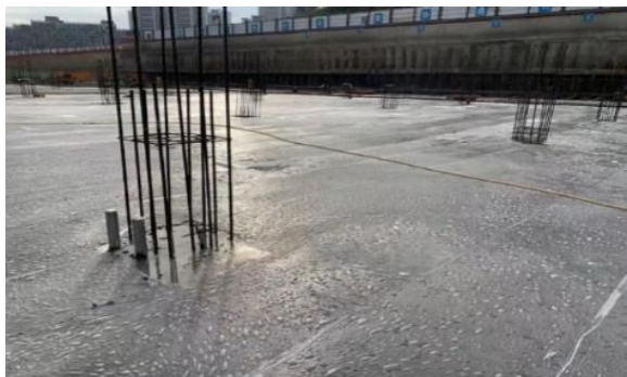
混凝土覆膜养护
