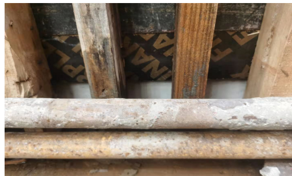
墙模板下挂防止错台
