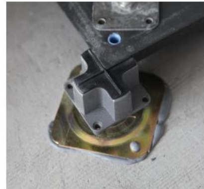
图 5.2.5 支撑底座安装
