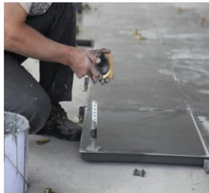
图 5.2.5 支撑底座安装
