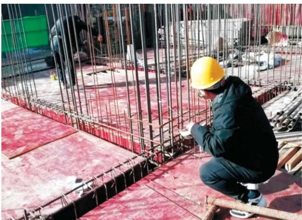
由于工期非常紧张，施工地点又在市中心居民区，各种条件限制施工难度大，材料只能选在夜晚进场。为了抢抓工期，这边材料进场的同时，那边项目部的技术负责人和工长正皱着眉头一块一块检查作业成果，组织开展验收工作，保证混凝土能按时正常浇筑。
