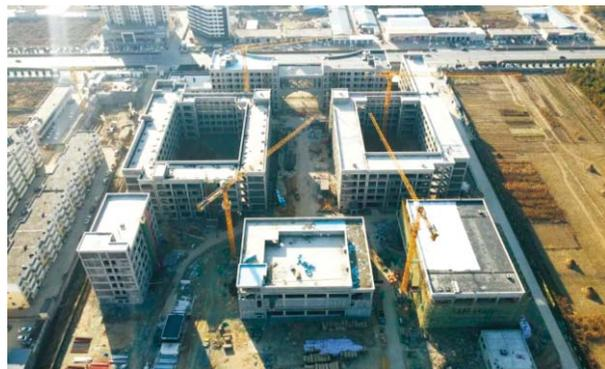
截至目前，该项目主体结构全部完成，二次结构全部完成，抹灰工程完成80%，中学教学楼窗框安装完成80%。
