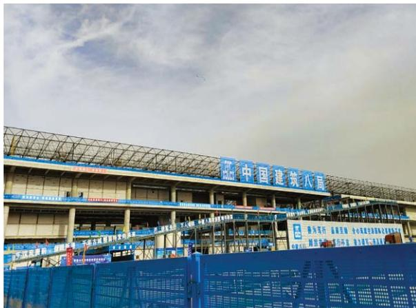
据了解，该项目混凝土主体结构已全面封顶，钢结构屋盖成功合拢，正在进行金属屋面、玻璃幕墙施工。同时，二次结构及精装修已进入收尾阶段，机电安装，行李系统钢平台等专业正在全面穿插施工，项目机器不停，工人不停，进度不减，正向着金属屋面、玻璃幕墙施工节点目标进行冲刺。
