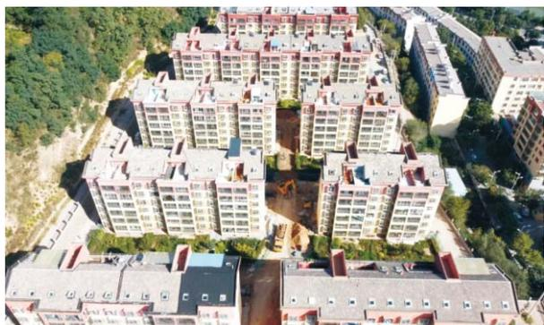
截止目前，该项目暗坑处理、化粪池吊装、围墙抹灰、给水管道、消防井、水表井砌筑已完成，道路硬化、强弱电安装、停车位铺装、暖通、排水管道等预计5月份完成。
