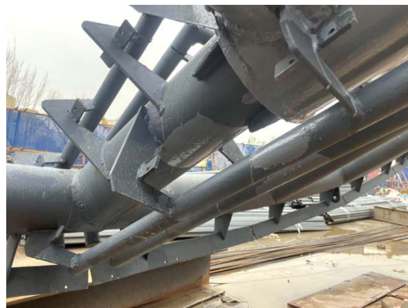
膜结构施工照片
