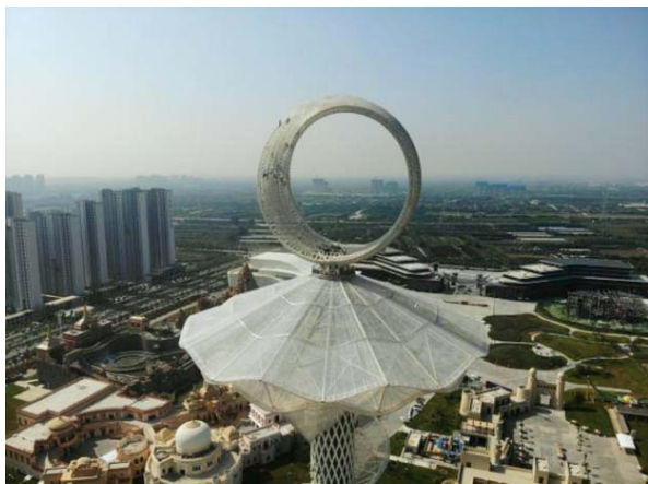
完工现场照片
