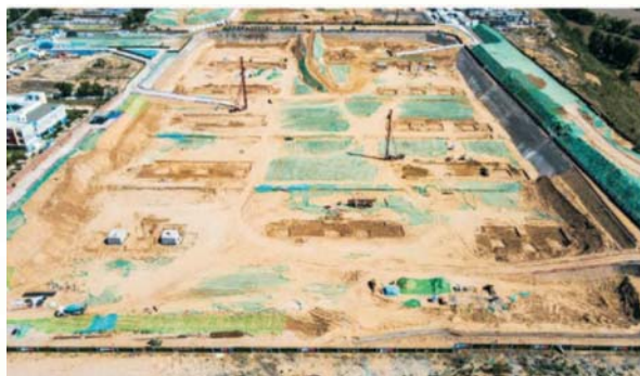
施工现场航拍
