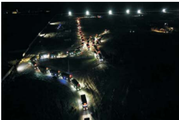
夜间施工现场
