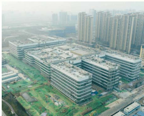
西安交通大学附属泾河医院项目施工现场
