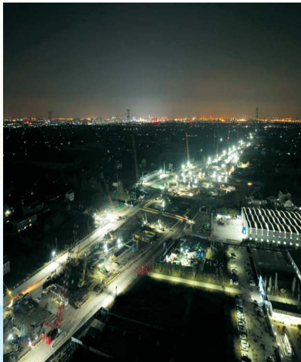
海门北站核心区夜间施工现场
