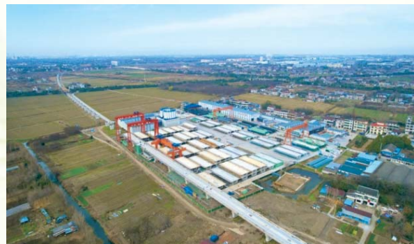
南通特大桥成型段落
