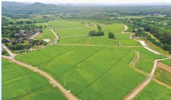
广东省汕尾市海丰县土地整治项目
