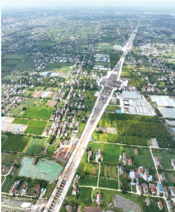
海门北站及进出口隧道施工全景
