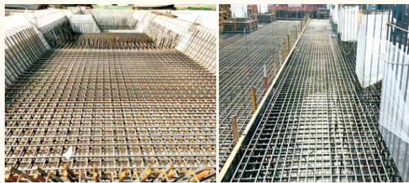
筏板钢筋施工
