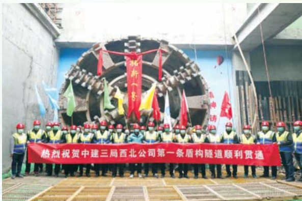
基础设施分公司承建的西安地铁14号线项目首条盾构隧道贯通
