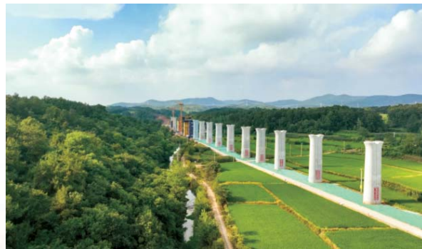
钱湾村特大桥墩身施工
