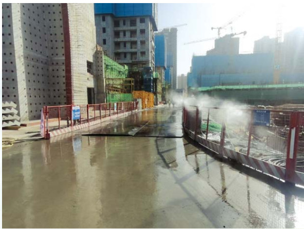
绿色施工：基坑喷淋
