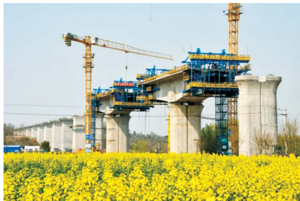
施工中的仙居河连续梁
