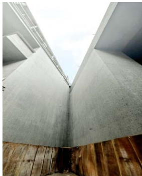
19.1米超高、25° 锐角竹纹清水墙体
