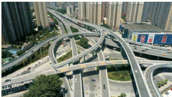
基础设施分公司承建的西安市新兴南路项目
