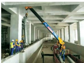
接触网第一杆组立
