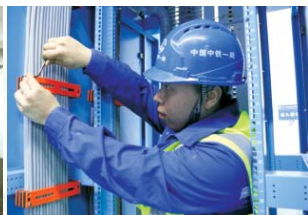
信号系统施工
