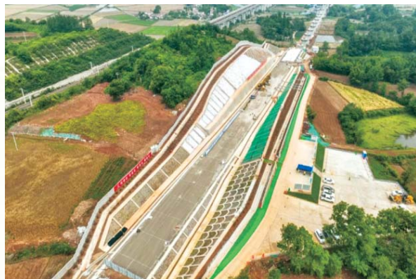
无砟轨道路基首件工程
