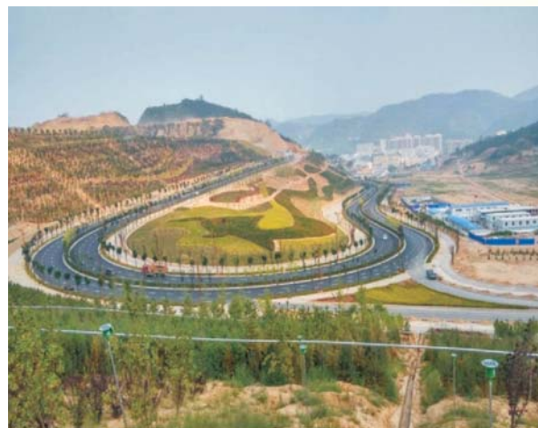
基础设施分公司承建的延安市桥沟道路项目
