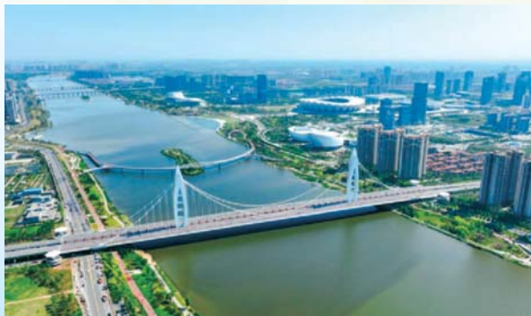
基础设施分公司承建的灞河元朔大桥
