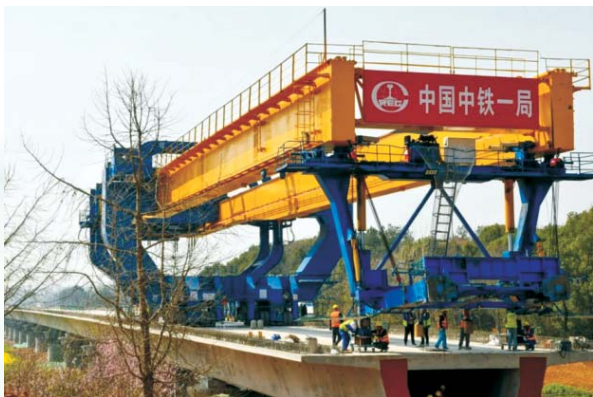
戴家湾大桥架梁
