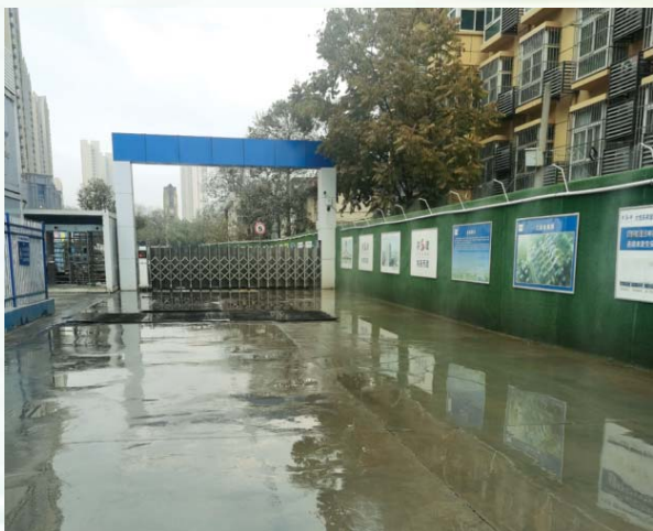
绿色施工：道路全硬化
