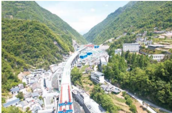
基础设施分公司承建的安岚高速项目（在建）
