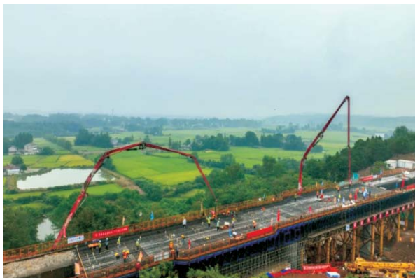
吊桥坪大桥道岔连续梁施工
