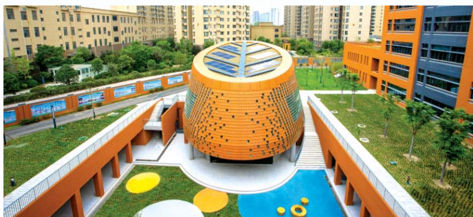
教学楼（三星绿建+超低能耗建筑）
