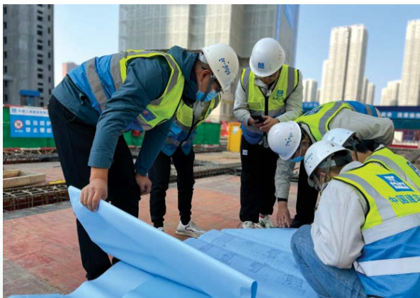
党员履约攻坚小组现场研究施工工艺
