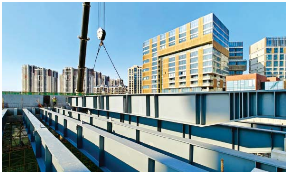
钢结构吊装和成品
