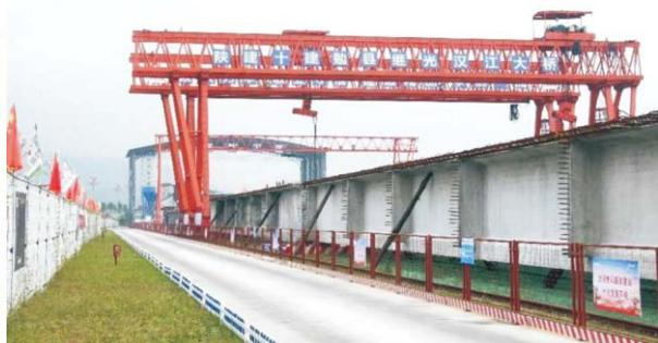
整洁；对现场临时道路进行硬化，既满足施工需要，又能避免施工扬尘的产生和道路泥泞情况的出现。
