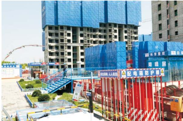
井洞口防护中，上部固定装置进行优化，采用可调高度固定装置，安全可靠。后浇带防护及定型化走道，基坑安全通道，承载力强，整体稳定性好。施工现场设置了微型消防站、悬挂式自动灭火器、投掷灭火球，安全防护用品等，加强现场安全应急设施保障。采用临边洞口作业夹具，测量控制点安全防护，塔吊采用人脸识别系统，防碰撞系统，吊钩可视化，电缆排线夹具，全钢附着式升降脚手架等设施工艺和设备，筑牢了安全屏障。
