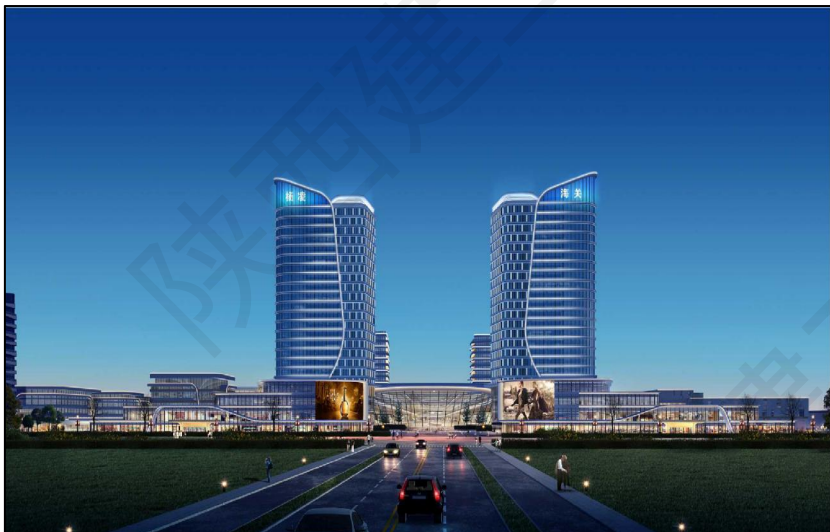
杨凌综合保税区一期工程EPC总承包项目
