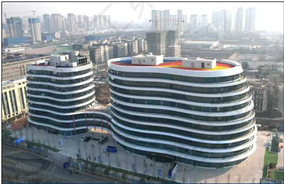
外立面航拍图
