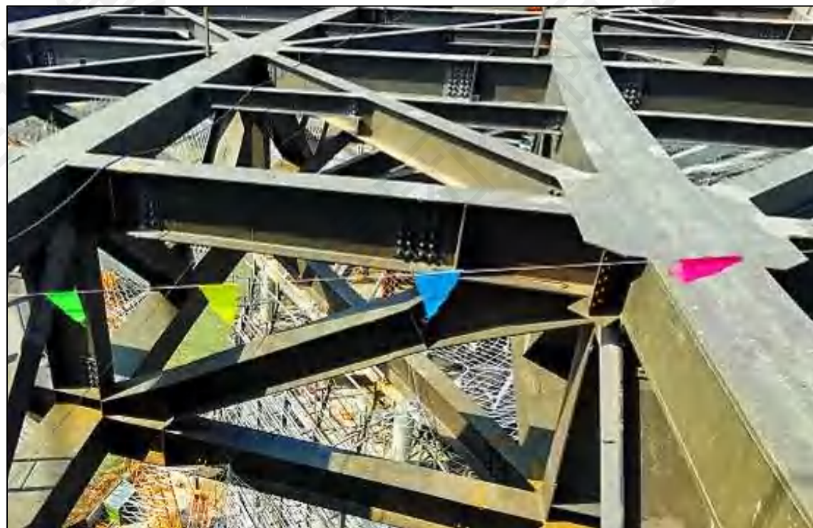
大跨度钢结构构件
