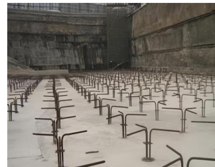
防水施工前抗浮锚杆弯折成形
