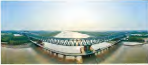
聊泰铁路黄河公铁桥
