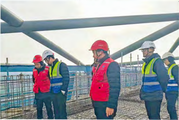
现场钢筋检查
