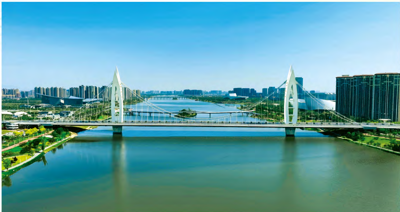
元朔大桥实景图
