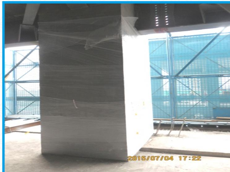
核心筒剪力墙喷淋养护
