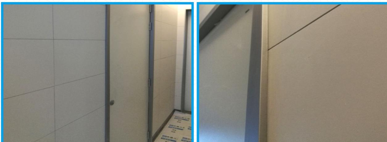
瓷砖饰面自然留缝及不勾缝，可有效防止瓷砖后期因热胀冷缩等外力造成空鼓起跷等现象。瓷砖墙面与不锈钢门套线接缝处不打胶，对两种材质基层及饰面垂直度及平整度要求高，使工程质量又提升档次。
