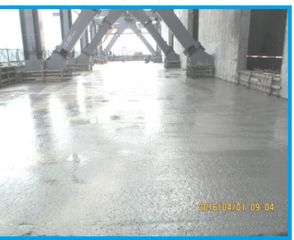
楼承板浇筑混凝土
