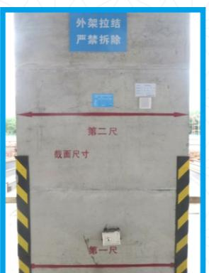
柱成品保护及实测实量标识
