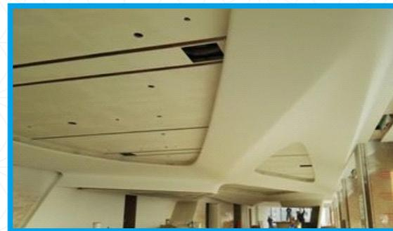
天花与墙面GRG板造型融为一体，对装饰基层施工，弱电，安装暖通布管及电气综合布线准确度要求较高。
