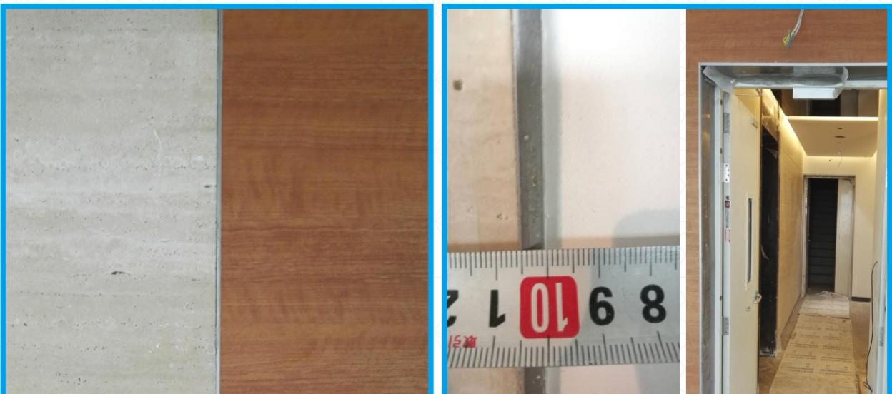
不同材质的墙面收口，利用不锈钢凸槽或门套进行分割，目前5mm宽度不锈钢压条已是国内领先水平，且该收口方式可有效避免两种材料的平整度误差，收口精致。
