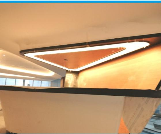
GRG造型复杂，经过BIM深化排版下单，安装后，经过处理无缝拼接，且不会开裂。
