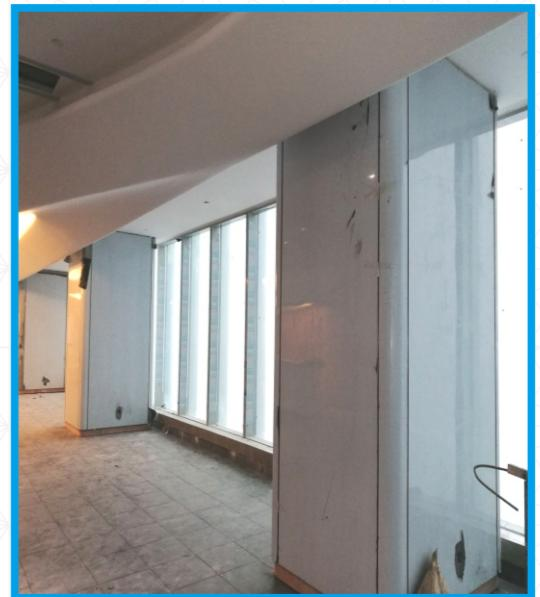
外框柱不锈钢饰面横向无接缝、竖向转角采用凹槽及背蜂窝，有效避免因平整度偏差影响整体效果，且使柱子造型丰富。
