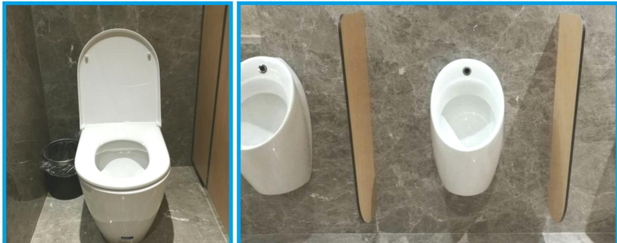
卫生间石材墙地面排版的整体效果，根据马桶及小便器，进行三等分，把马桶、小便器、成品隔断放到缝中，石材墙地面对缝，确保整体效果美观。
