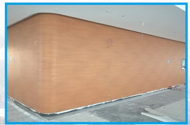
核心筒外围墙面大面积采用波音软片饰面，基层处理高标准要求并采用定制单卷50米长，有效减少竖向拼接缝，确保大面积整体无色差、木纹顺直，并与墙面木纹洞石纹路相互呼应，完美达到设计效果。
