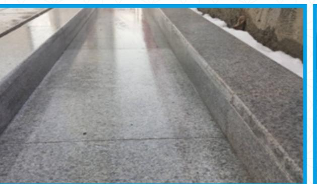
天沟石材铺贴坡度准确，沟边石材倒角处理
