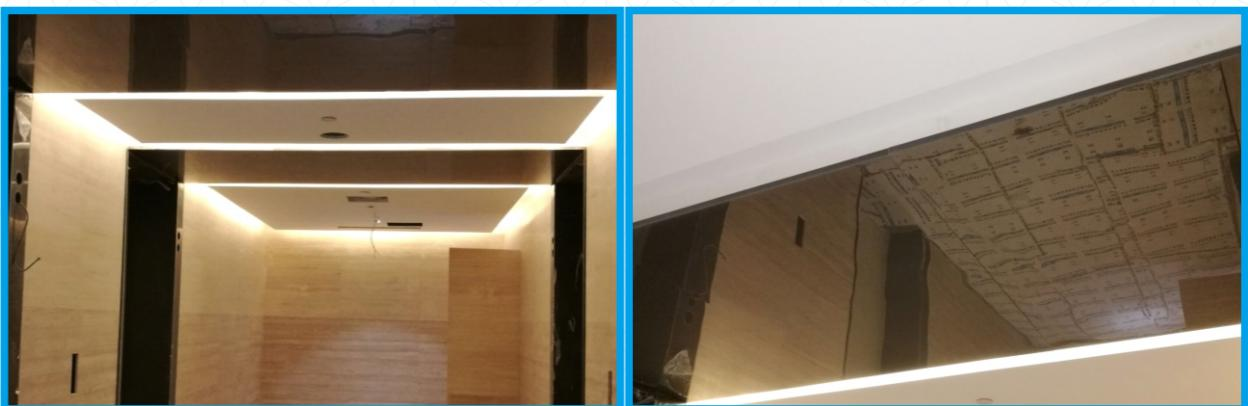
电梯厅吊顶采用镀钛不锈钢，调出设计指定颜色，确保整体效果要求。
