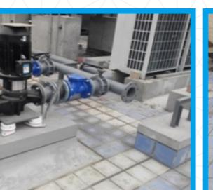
屋面设备隔震措施到位、放线精准定位
