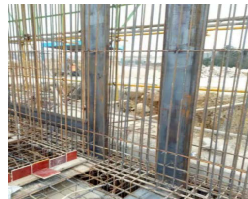
外墙后浇带钢板止水带安装
