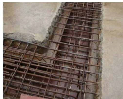
后浇带浇筑封闭前基层清理及凿毛
