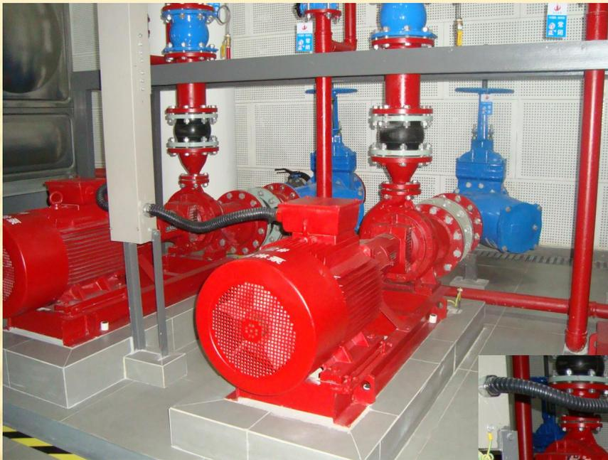
12.消防水泵与基础硬连接，未采取减振措施。
