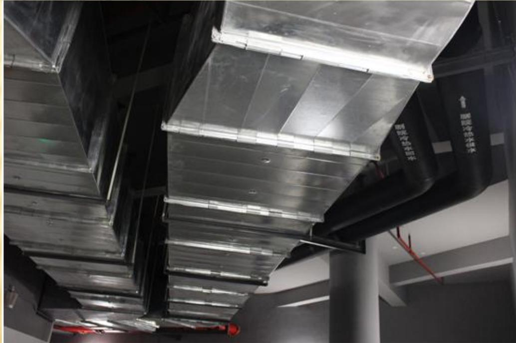
20. 风机房内管道支架油漆黑黄间隔，间距均匀，既防腐又起到了警示作用，根部凸台平面尺寸及标高一直，防水防腐。
