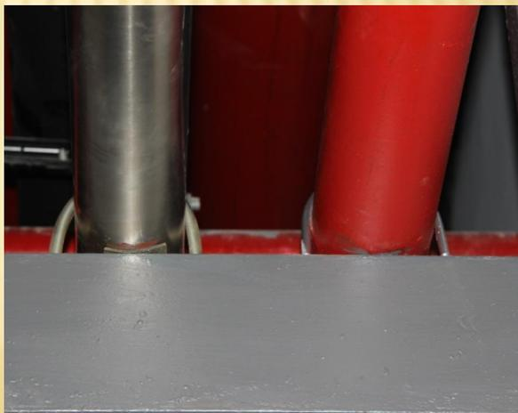
14、设备减振设置合理；基础周围**排水槽**设置美观；管道与地面、支架与地面连接处，采用**成型减震器**减震，防水、美观。
