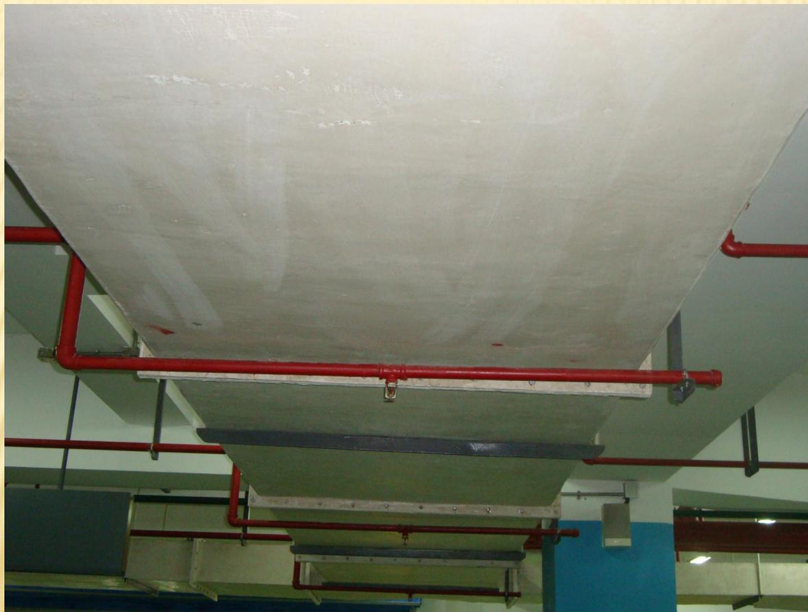
18、舞台上方雨淋系统与舞台机械配合难度大，经精确定位、合理布置，满足功能和观感要求。
