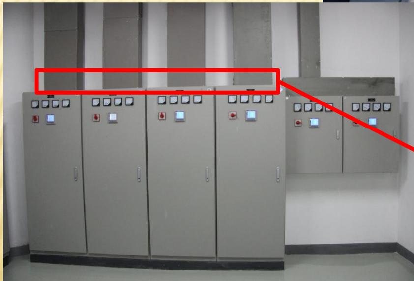
桥架、配管和箱内PE排未接地跨接
