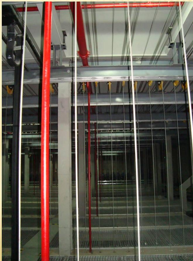
19 风管制作安装平整，直线度好，法兰连接卡口间距均匀，牢固，符合规范要求。吊架间距均匀，吊杆长度一致，所有明露吊杆外加塑料套管，美观漂亮，并起到了防腐作用。
