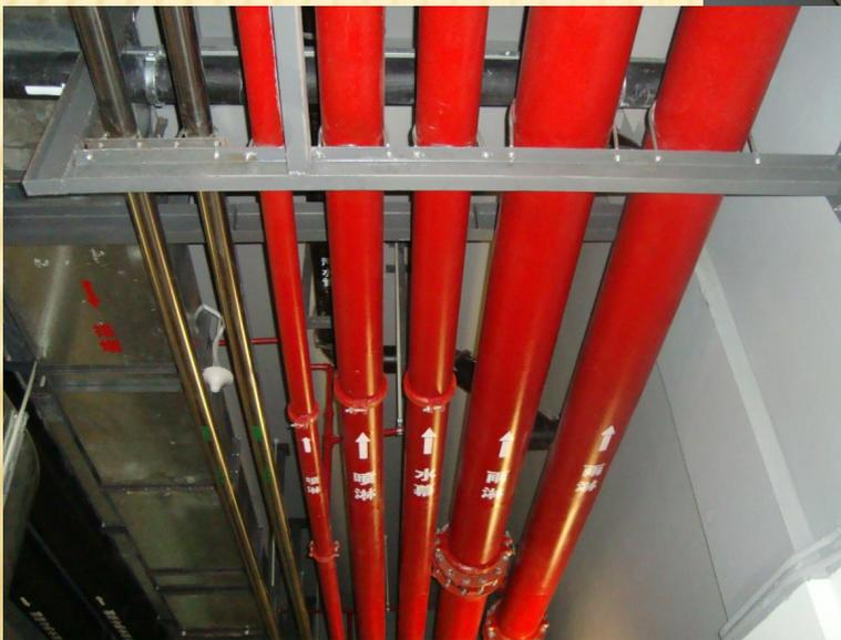
6.消防喷头末端**不能用采用吊杆支架**，且水平距离太近，竖直方向支架离喷头过远。
