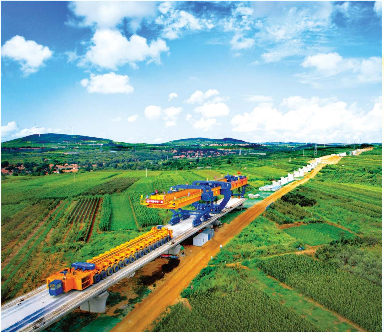
国内自主研发的JQ900B箱梁架桥机在濉烟高铁冶王村特大桥进行箱梁架设
