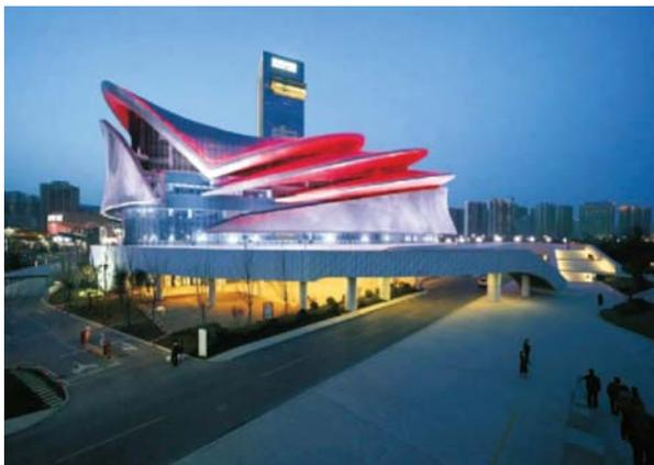
项目造型屋面及外幕墙系统共由五片羽毛状结构组成。表皮全部为开缝设计，表皮系首次使用无光精轧国产钛板，造型复杂，板式多样，项目通过此技术形成羽状多曲无光精轧国产钛板施工工法，并形成自主知识产权一项，有效提高了钛板的安装精度。
