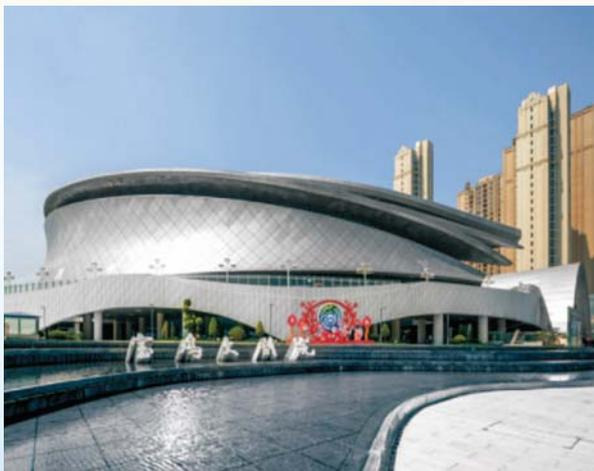
项目科学计划，加压奋进，克难攻坚，周密穿插，密切配合施工。17天，完成10万方土方开挖外运；90天，完成绑扎钢筋3800吨浇筑地下混凝土2.2万方；90天，完成地上主体钢结构支架安装；120天，大剧院成功封顶……
