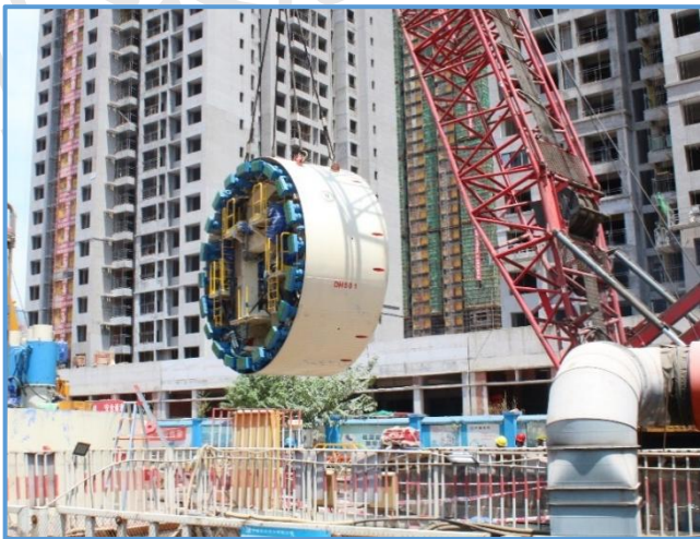
图8-147 盾构机吊装
