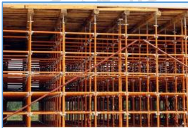
图4-16承插型轮扣式支撑顶托设置 (2)
