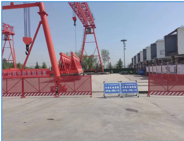
图6-162 龙门吊封闭及警示
