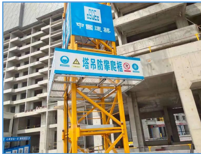
图6-18 塔吊防攀爬装置（方案B）
