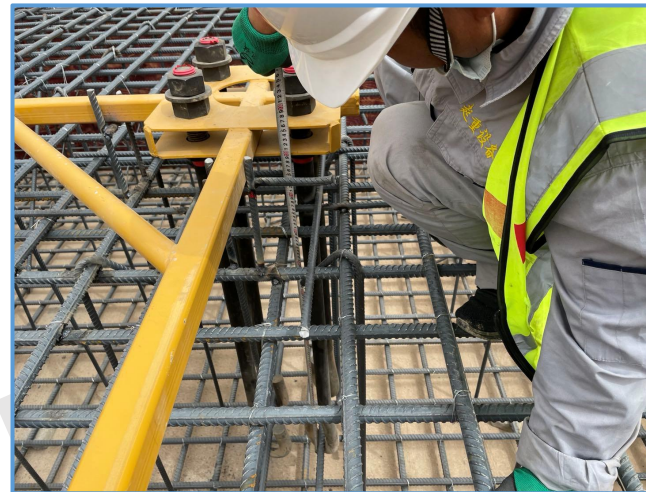
图6-6 塔吊基础隐蔽验收
