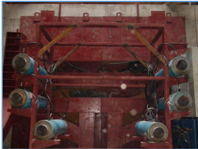
图8-34 顶管后背墙设置
