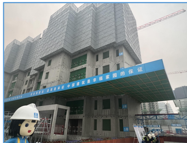
图7-54 悬挑式水平防护网（4）
