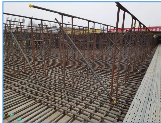
图2-36 钢筋型钢筋支架
