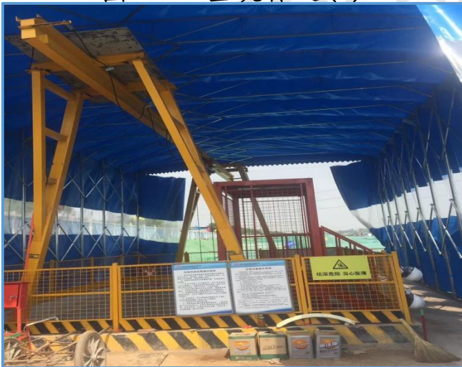
图8-29 移动式基坑防护棚
