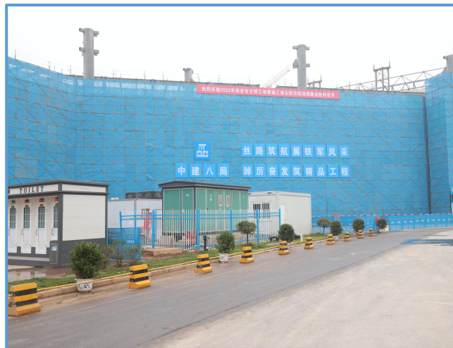
图3-10 脚手架外立面防护（4）
