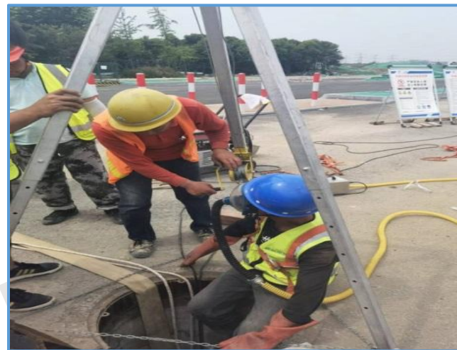
图8-49 作业人员装备
