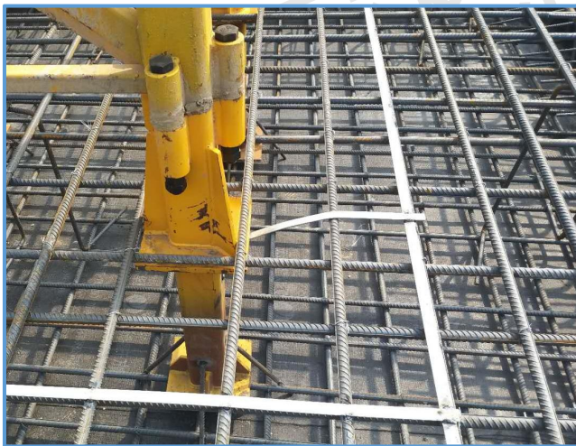
图5-33 塔吊接地示意图
