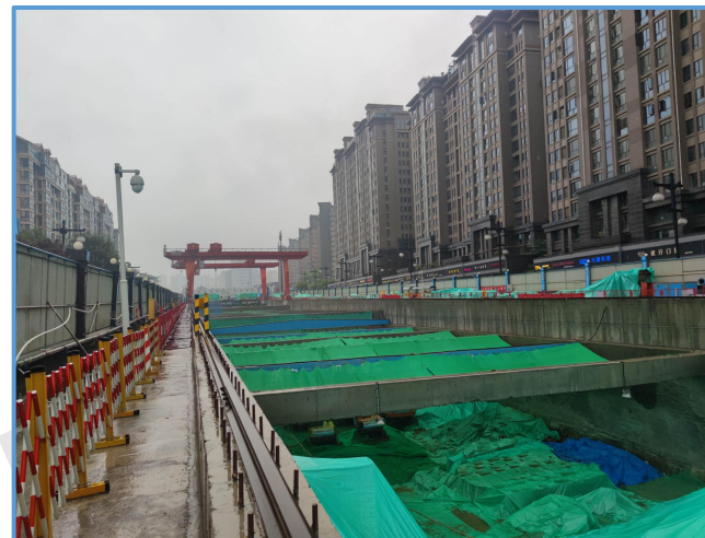
图2-7 基坑钢筋混凝土内撑支护（2）
