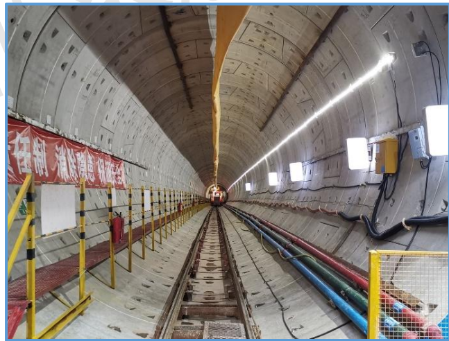
图8-161 洞口管片槽钢拉结、限位
