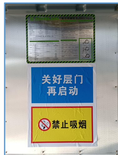
图6-80 施工升降机笼内提示标语
