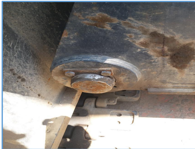
图6-134 履带吊零部件安装完好
