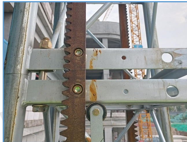
图6-102 施工升降机齿条固定
