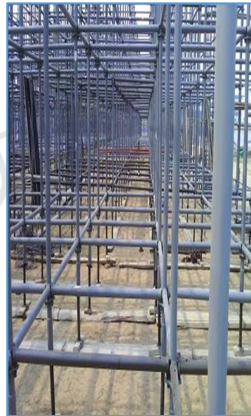
图4-15 承插型轮扣式支撑立杆设置
