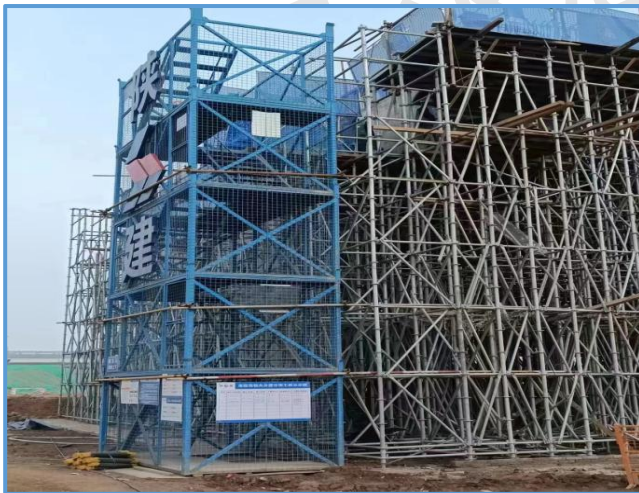
图8-62 支架上下梯道
