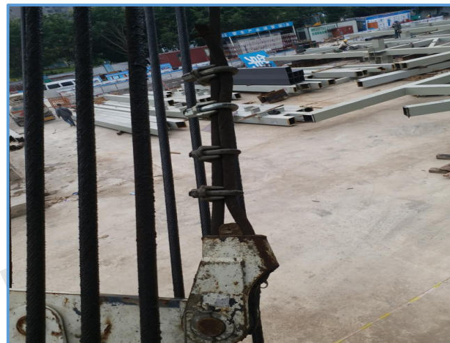
图6-143履带吊绳头绳夹按要求安装
