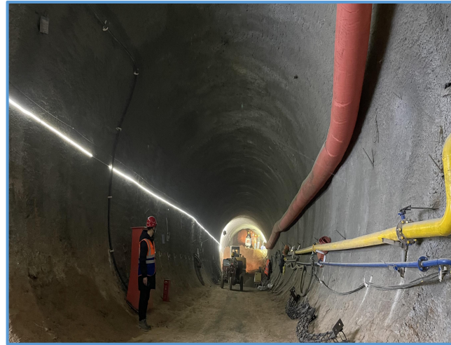
图8-89 隧道支风管（2）
