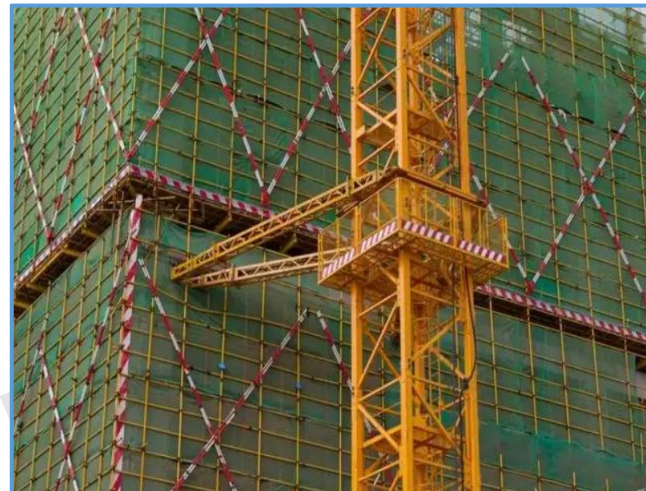
图6-14 塔吊附墙操作平台（方案B）
