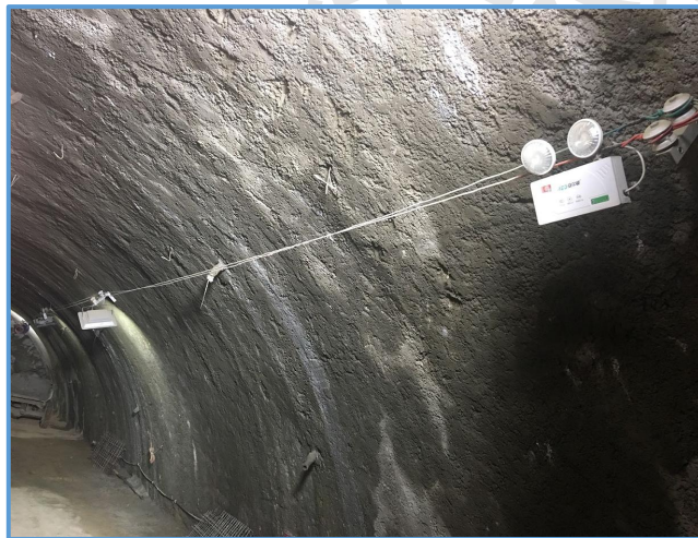
图8-96 隧道LED节能灯照明
