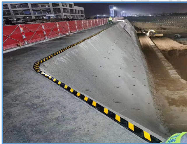
图2-4 土钉墙支护（2）
