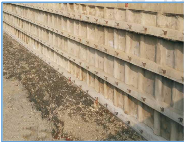
图2-6 基坑桩锚支护（2）
