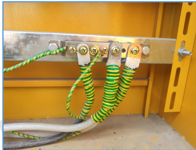
图5-22 PE线接线端子
