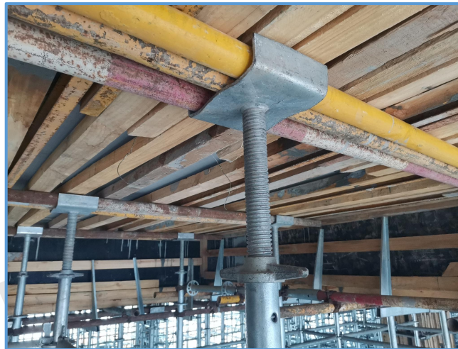
图4-3 承插型盘扣顶托设置（2）
