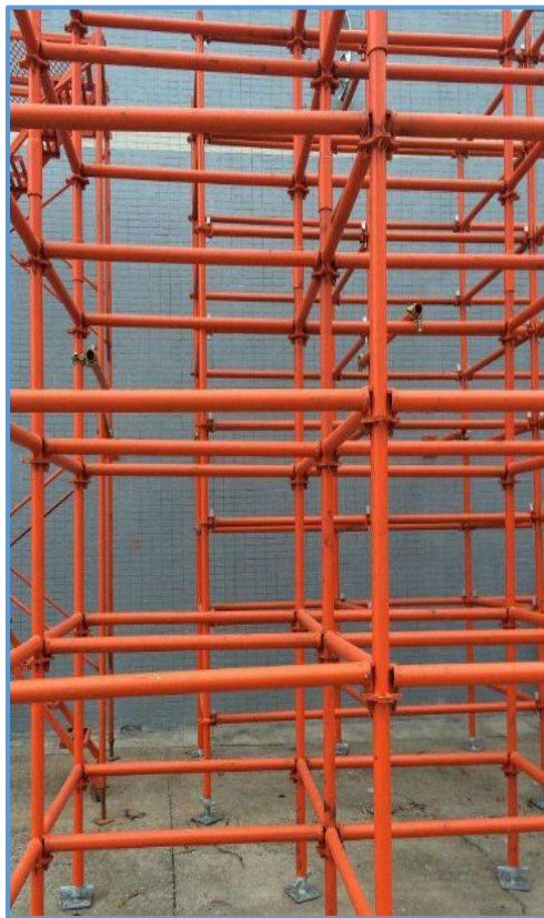
图4-14 承插型轮扣式支撑水平杆设置
