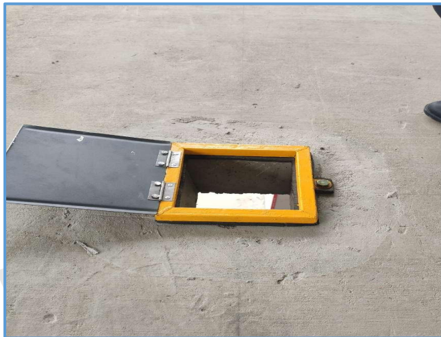
图7-26 定型防护盖板
