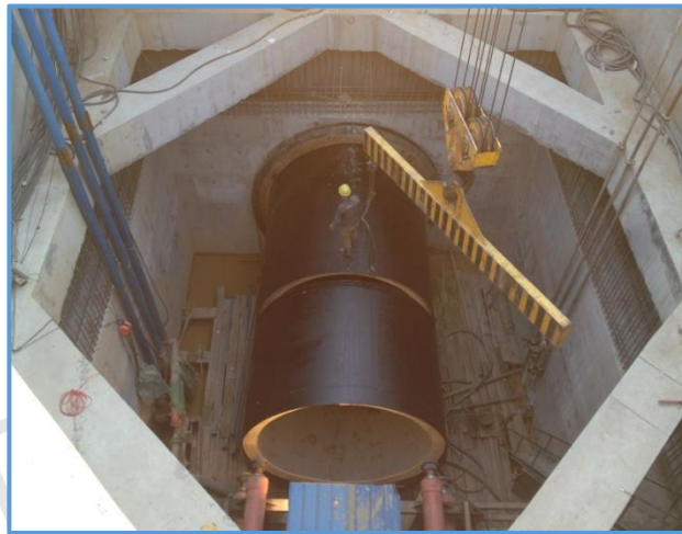
图8-33 顶管顶进方法（泥水平衡）
