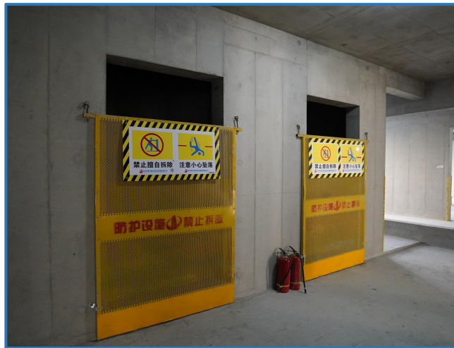
图7-31 电梯井洞口立面防护（2）
