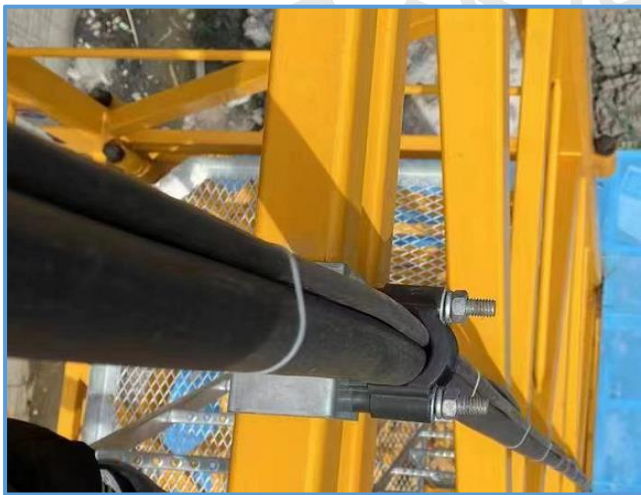
图6-35 塔吊主电缆绝缘、卸载
