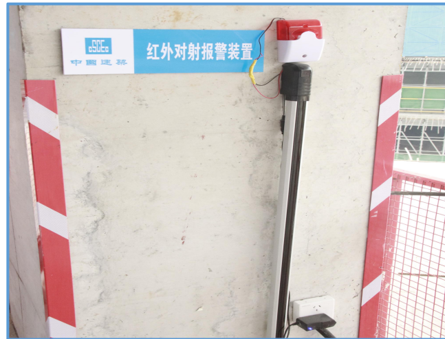
图7-37 红外射频临边报警系统
