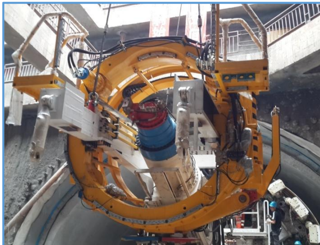
图8-148 管片拼装机安装
