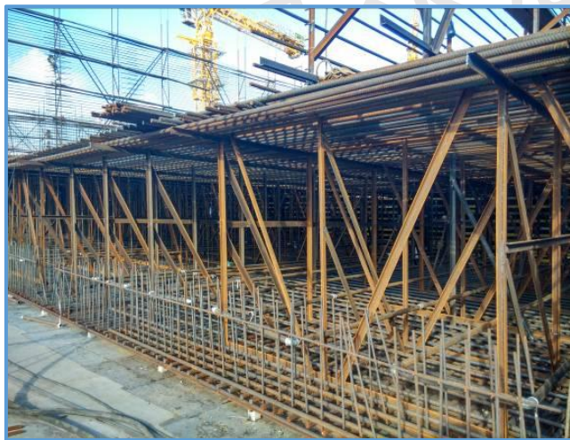
图2-35 角钢钢筋支架
