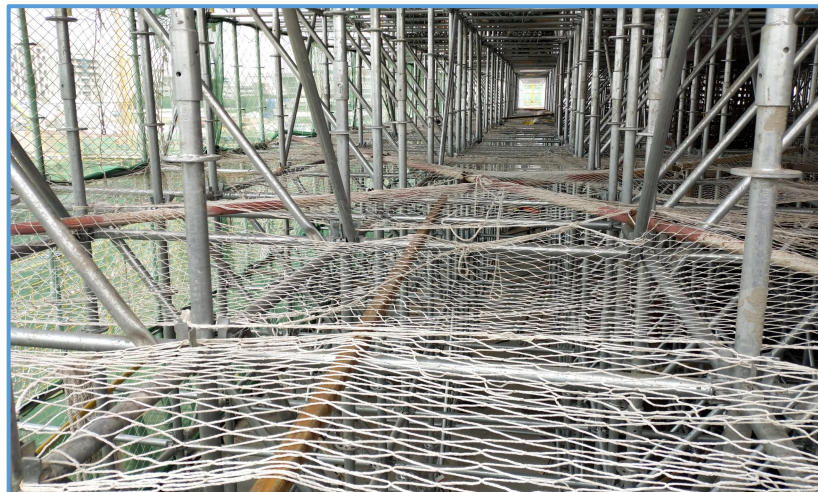
图4-5 承插型盘扣支撑架斜拉杆、安全网设置
