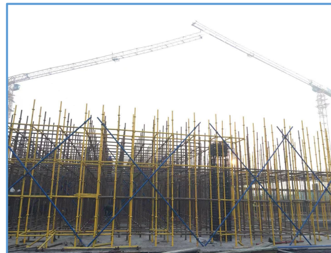
图4-12 扣件式钢管支撑剪刀撑设置（4）
