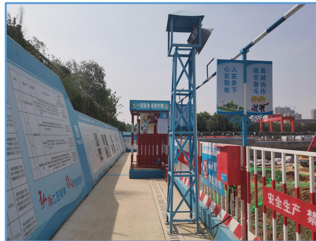
图2-19 基坑镝灯照明
