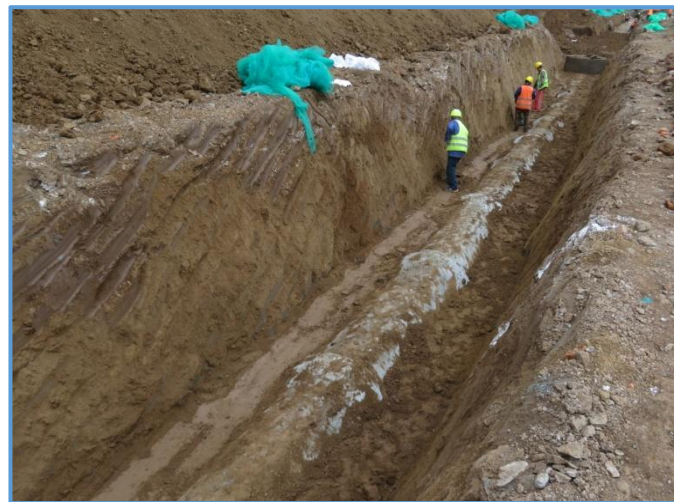
图8-24 沟槽回填(1)
