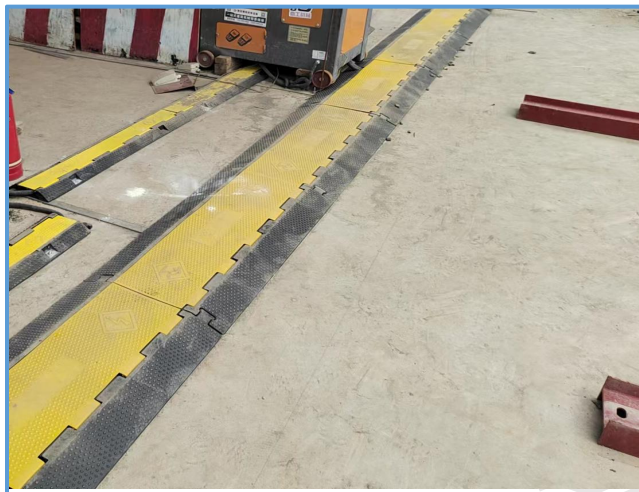
图5-12 电缆采用橡胶线槽线进行过地保
