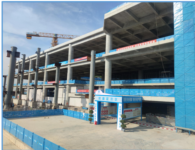
图7-34 定型化临边防护栏杆
