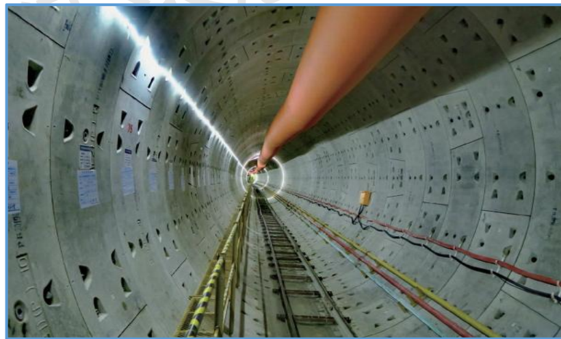
图8-133 洞内风管布置
