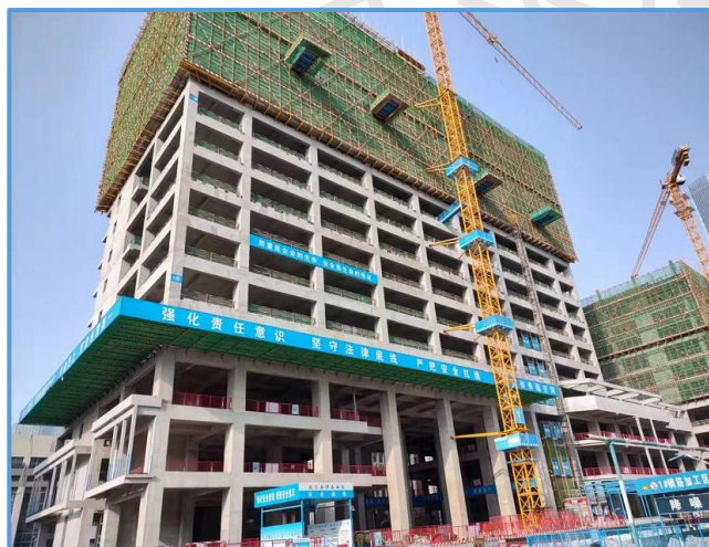
图7-54 悬挑式水平防护网（3）
