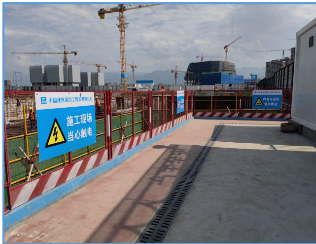
图2-17 基坑临边防护（1）
