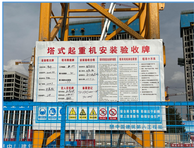
图6-64 塔吊安装验收牌
