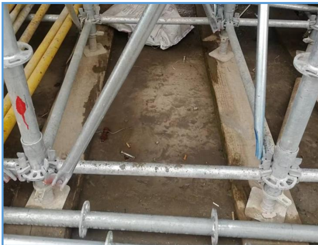
图8-56 支架底托与基础
