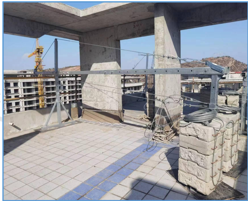
图3-37 吊篮悬挂机构
