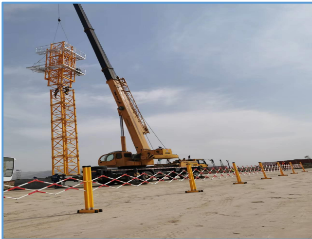
图6-9 塔吊安装警戒
