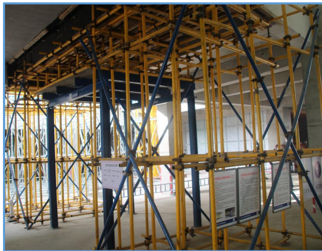
图4-22 后浇带支撑示意图（4）
