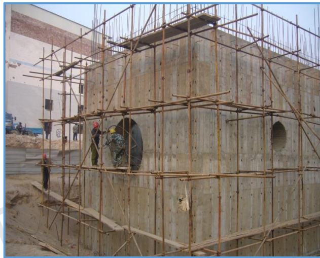
图8-25 基坑支护形式(沉井)
