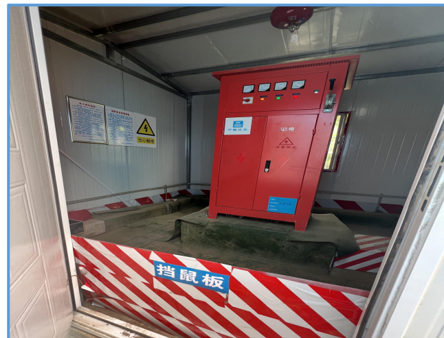
图5-11 设置挡鼠板
