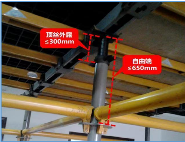
图4-16承插型轮扣式支撑顶托设置 (1)
