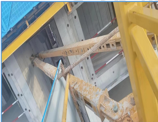
图6-43 塔吊附着装置
