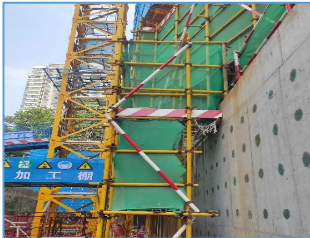
图3-5 横向斜撑示例图
