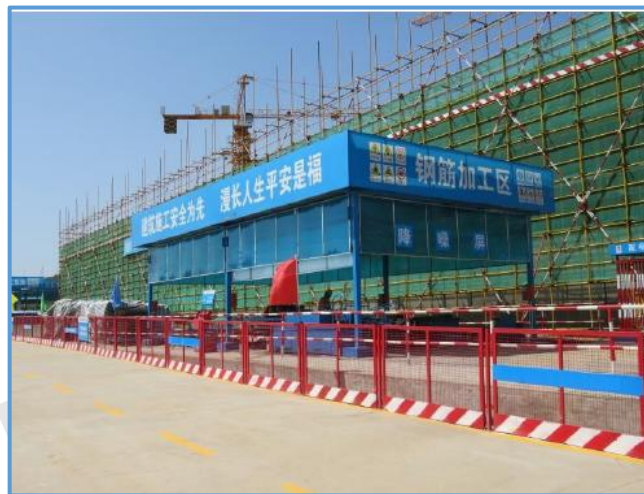
图7-46 半封闭式钢筋加工车间
