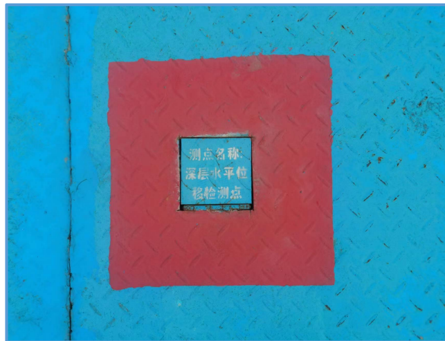
图2-25 基坑水平位移监测点
