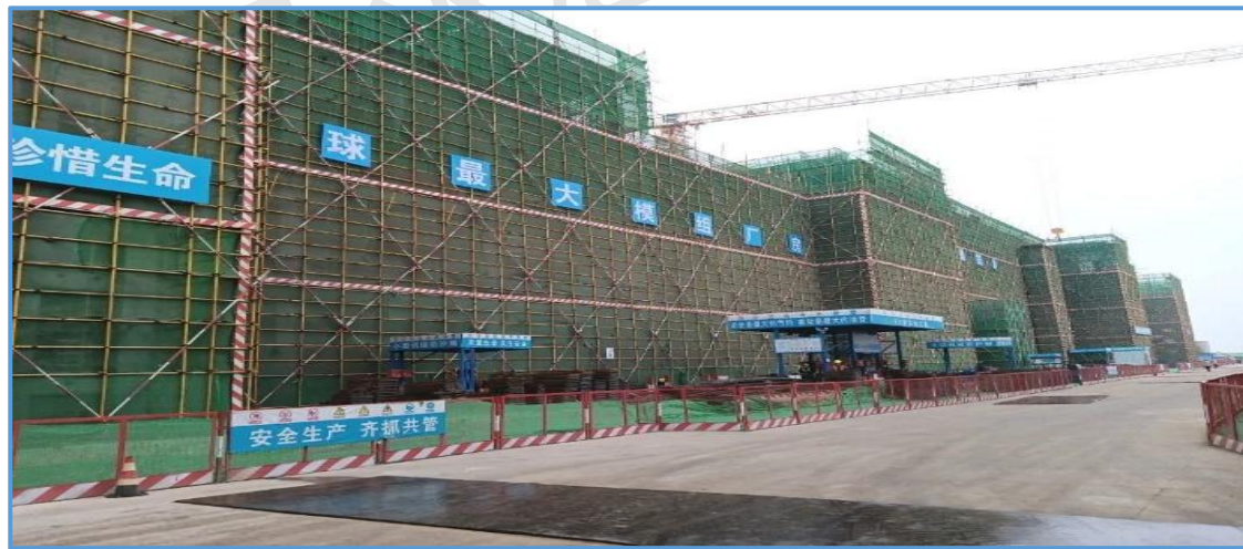
图3-7 24m以上剪刀撑搭设示例图
