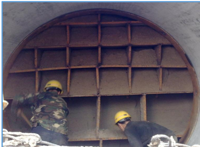
图8-33 顶管顶进方法（格栅挤压）
