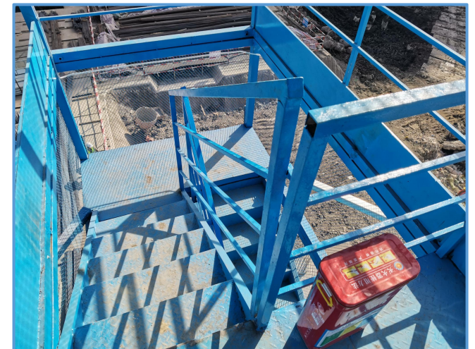
图2-31 基坑通道爬梯扶手（2）
