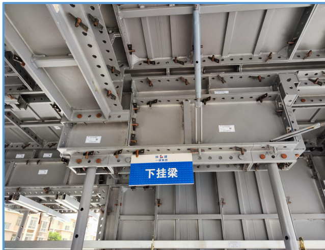
图4-18 铝模支撑安装（1）
