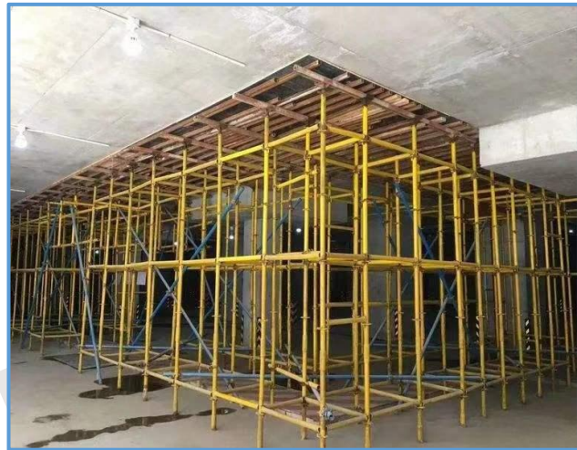
图4-22 后浇带支撑示意图（2）
