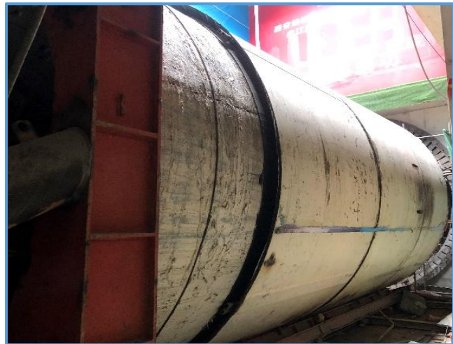
图8-160 负环管片脱出盾尾后钢丝绳拉结
