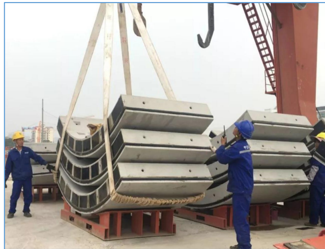
图8-152 16t龙门吊材料吊装
