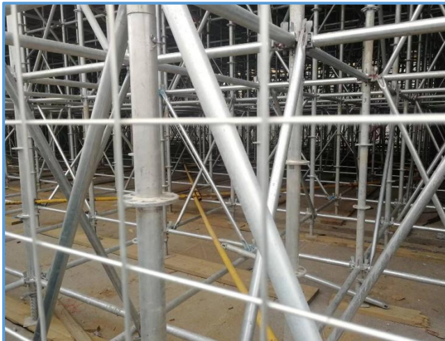
图8-60 支架水平剪刀撑
