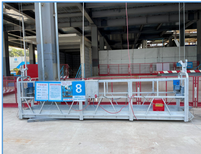
图3-38 吊篮操作平台
