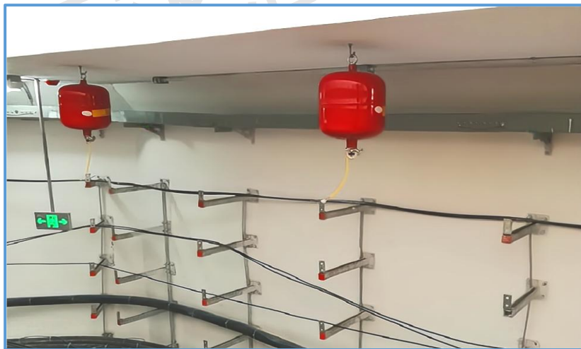
图9-73 感温自动灭火器（2）
