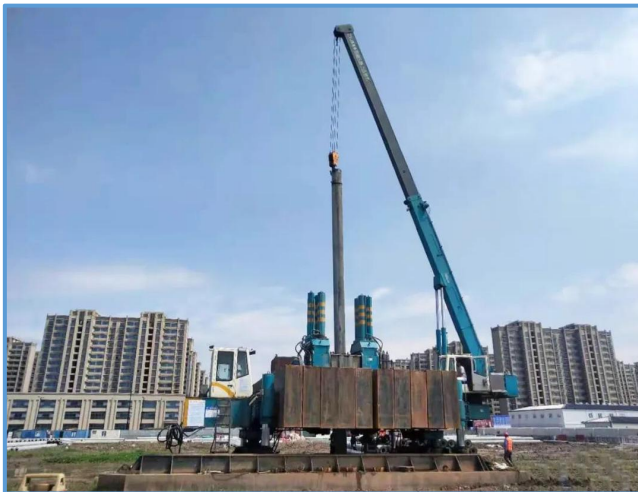
图6-186 桩机吊桩（1）
