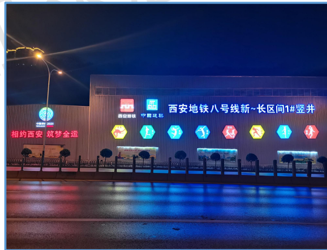
图8-75 全封闭厂棚实景图（夜间）
