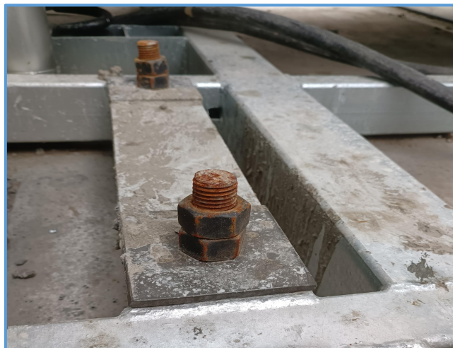
图6-97 施工升降机地脚螺栓连接
