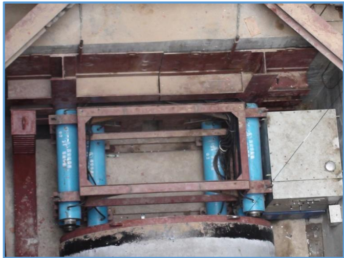
图8-38 千斤顶、油泵设置
