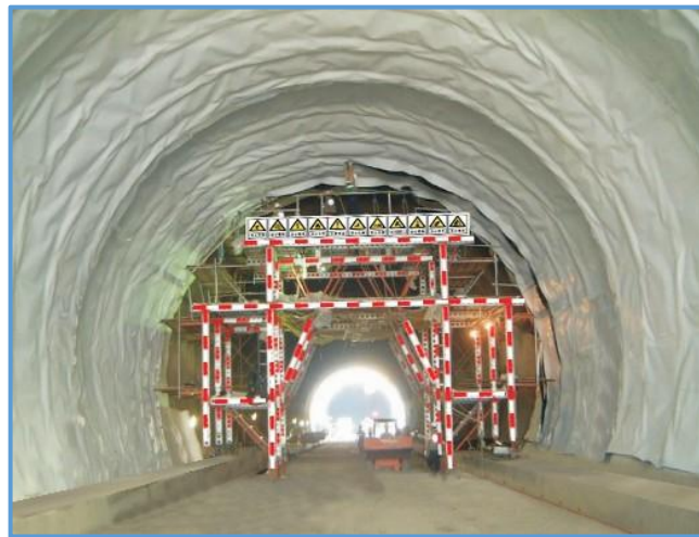
图8-106 隧道型钢作业台架
