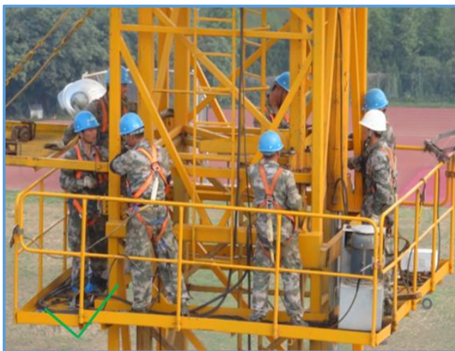
图6-12 塔吊安装过程
