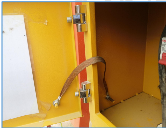
图5-23 箱门及箱体使用编织软铜线连接
