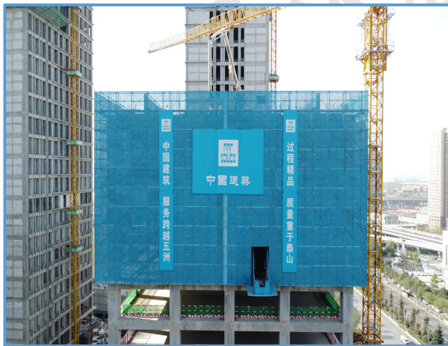
图3-21 外立面防护示例图 (1)
