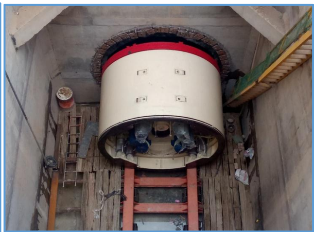
图8-40 顶管机安装
