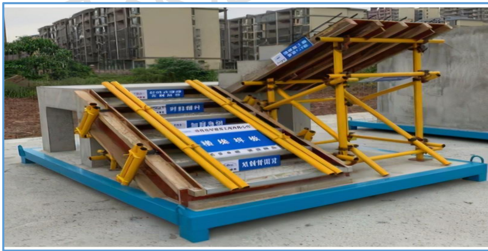
图4-23 楼梯支撑示意图（2）
