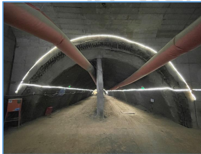
图8-89 隧道支风管（1）
