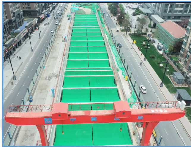
图2-10 钢支撑全封闭降尘天幕系统
