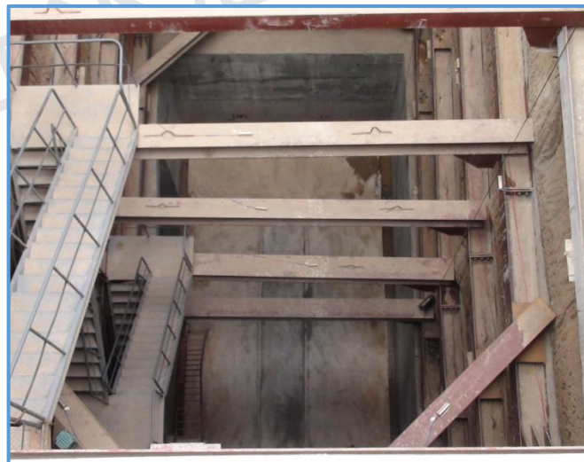
图8-25 基坑支护形式(灌注桩-型钢围檩)
