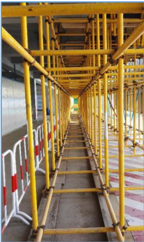
图3-1 脚手架基础示例图
