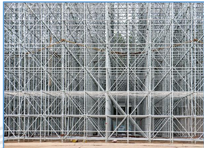
图4-1 承插型盘扣支撑架样板示意图（1） 图4-1 承插型盘扣支撑架样板示意图（2）
