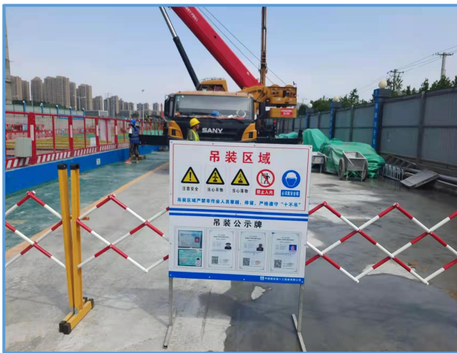
图6-125 汽车吊吊装警戒区域
