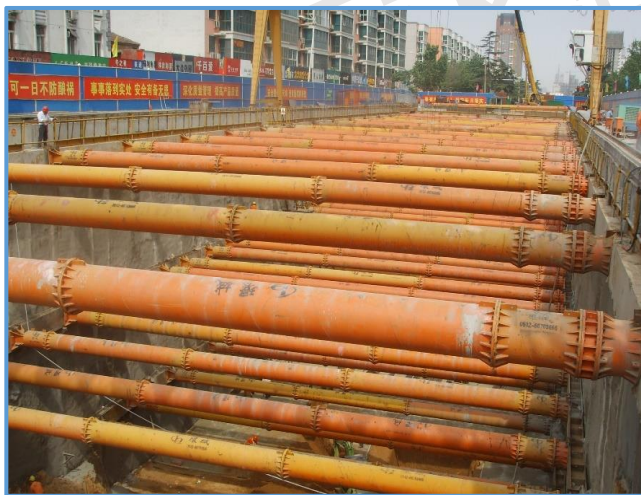
图2-11 钢支撑支撑支护（1）
