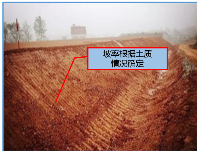
图2-3 基坑自然放坡
