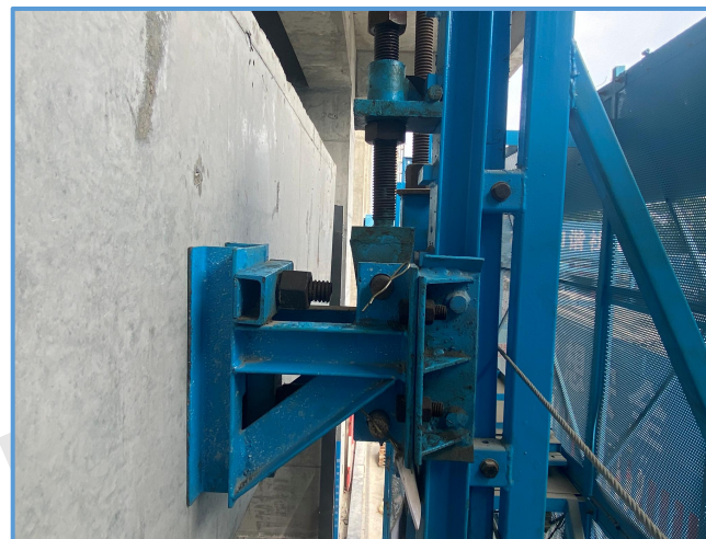
图3-27 附墙支座示例图（2）
