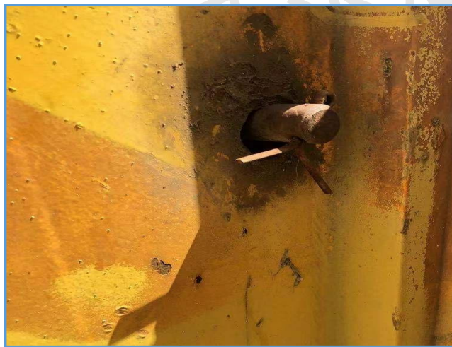
图6-193 桩机杆件连接
