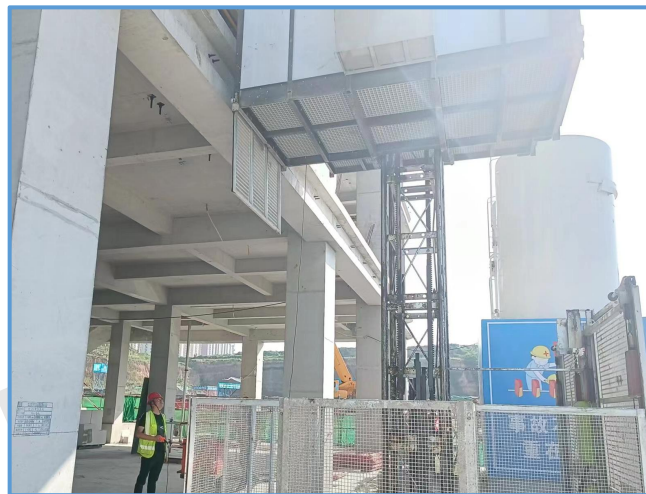
图6-70 施工升降机坠落试验
