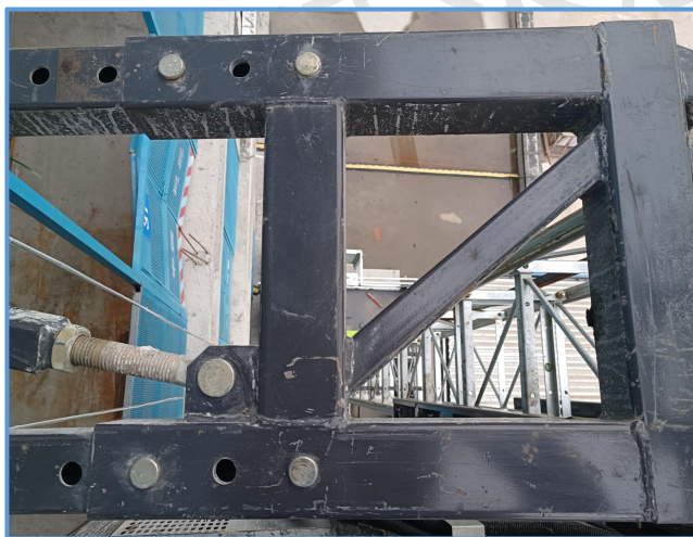
图6-107 施工升降机连接销轴
