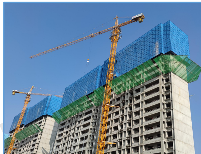
图7-54 悬挑式水平防护网（2）
