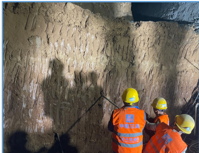
图8-112 超前地质探孔打设
