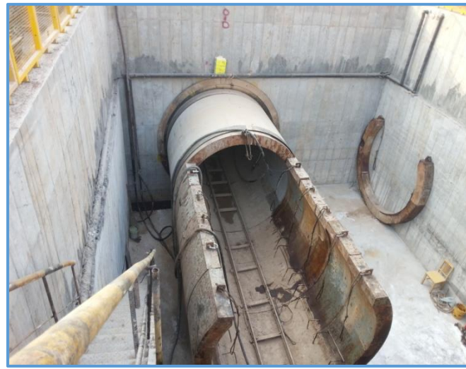
图8-37 顶铁与导轨
