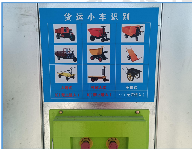
图6-79 施工升降机货运小车警示牌
