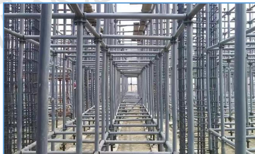
图4-13 承插型轮扣式支撑（2）
