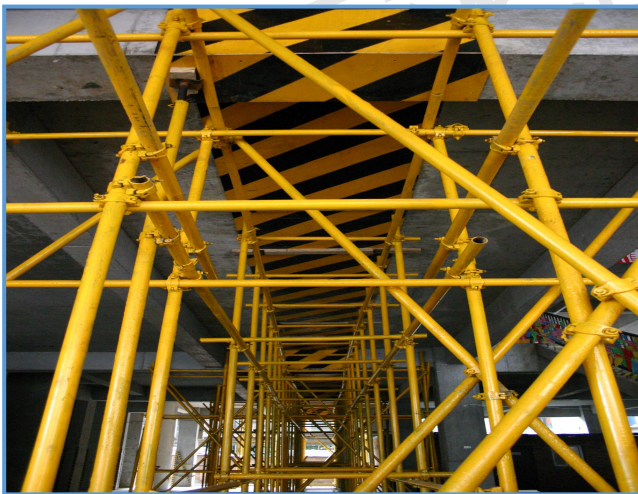
图4-22 后浇带支撑示意图（3）
