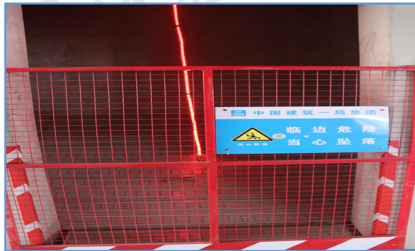
图7-33 伸缩式电梯井水平防护
