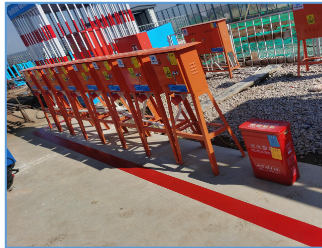
图5-29 配电箱高度1.4~1.6m
