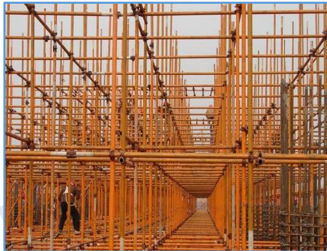
图4-7 扣件式钢管支撑立杆设置（2）
