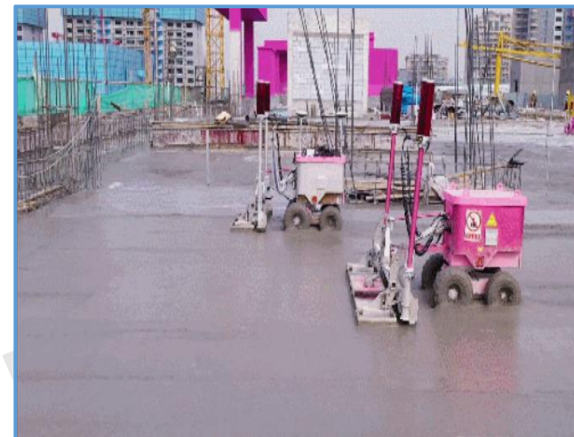
图9-78 混凝土整平机器人（2）
