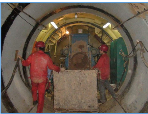
图8-33 顶管顶进方法（土压平衡）
