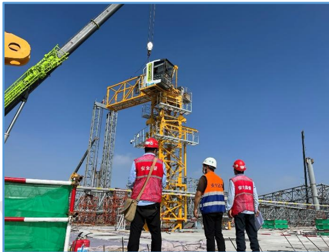
图6-10 塔吊安装旁站监督
