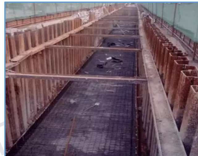
图8-18 沟槽支护形式(钢板桩)
