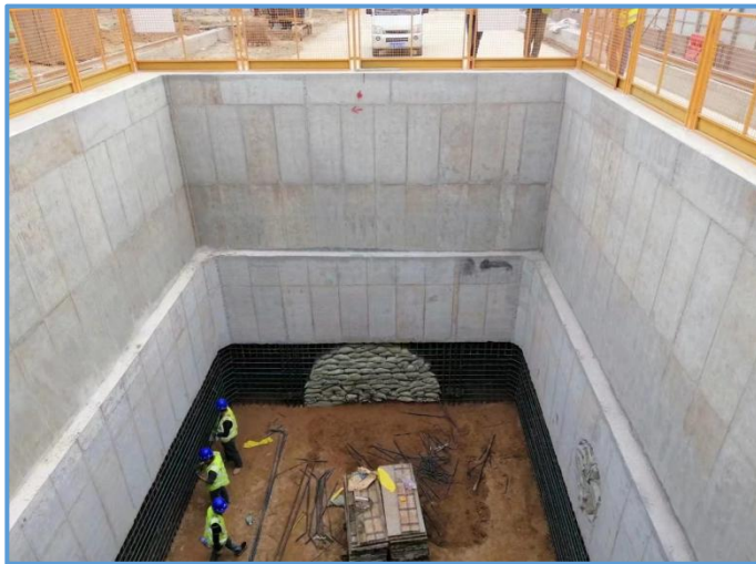
图8-25 基坑支护形式(逆作法)
