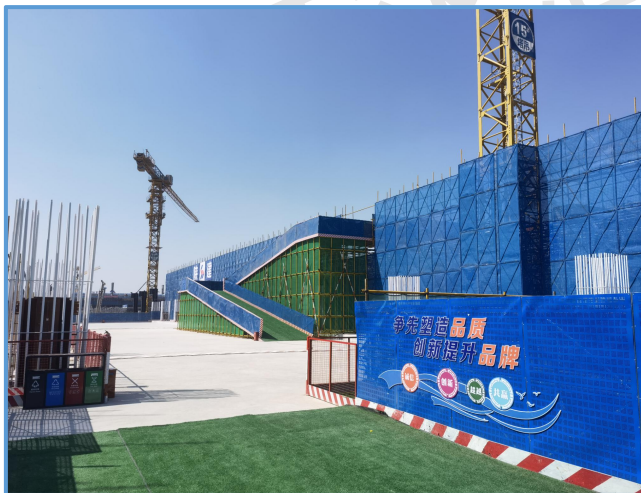
图3-10 脚手架外立面防护（3）
