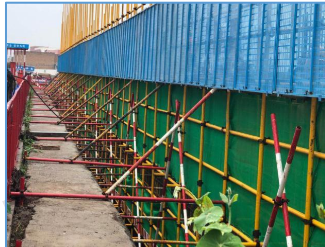
图3-3 连墙件设置（2）
