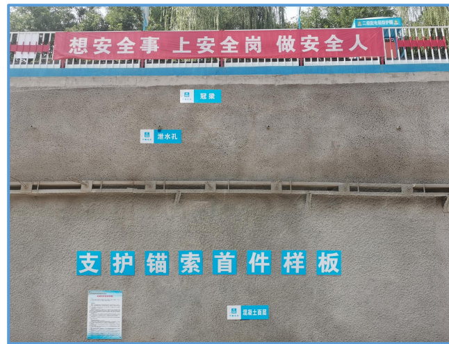
图2-6 基坑桩锚支护（3）
