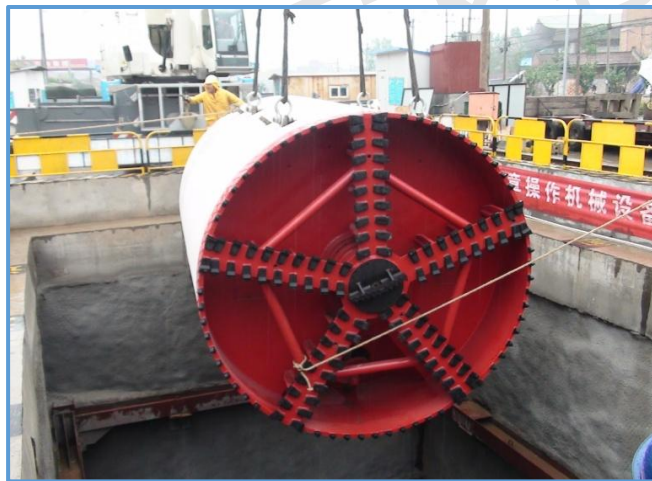
图8-39 顶管机吊装
