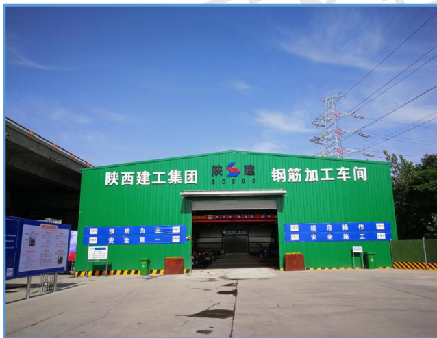
图7-47 封闭式钢筋加工车间
