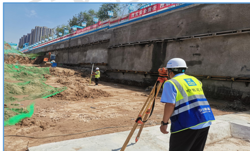
图2-2 基坑开挖标高及尺寸控制
