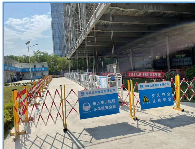
图3-41 吊篮防坠落半径围栏
