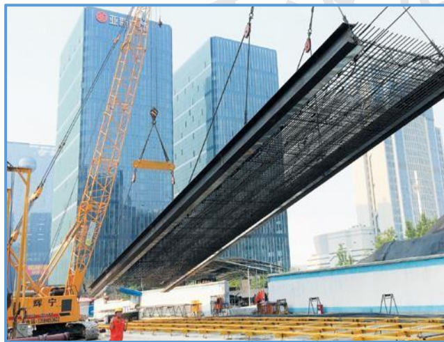
图2-14 地下连续墙钢筋笼吊装
