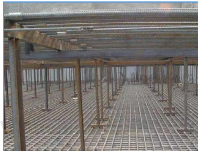
图2-34 方管钢筋支架
