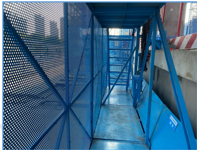
图3-20 水平支承桁架示例图 (2)
