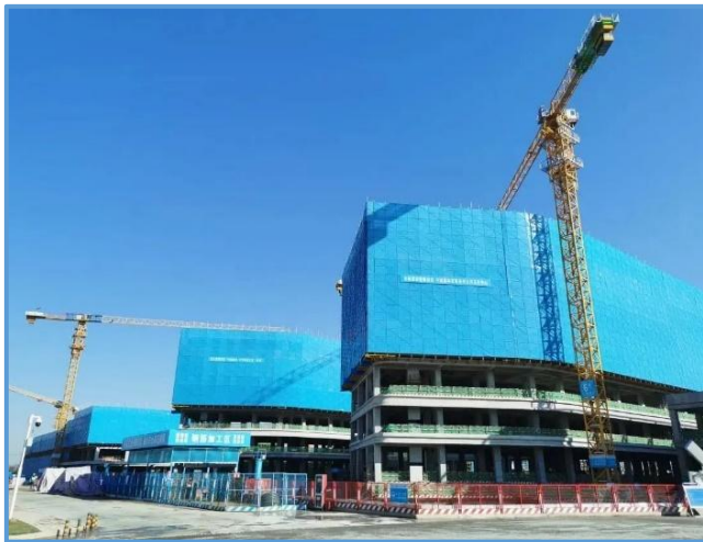
图3-10 脚手架外立面防护（1）
