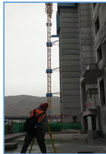
图6-40 塔吊垂直度测量 (附着高度垂直度)
