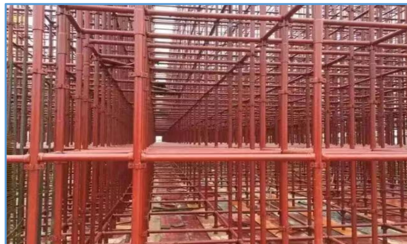
图4-13 承插型轮扣式支撑（1）
