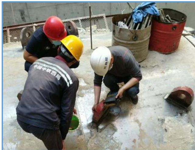
图8-146 盾构机吊耳探伤
