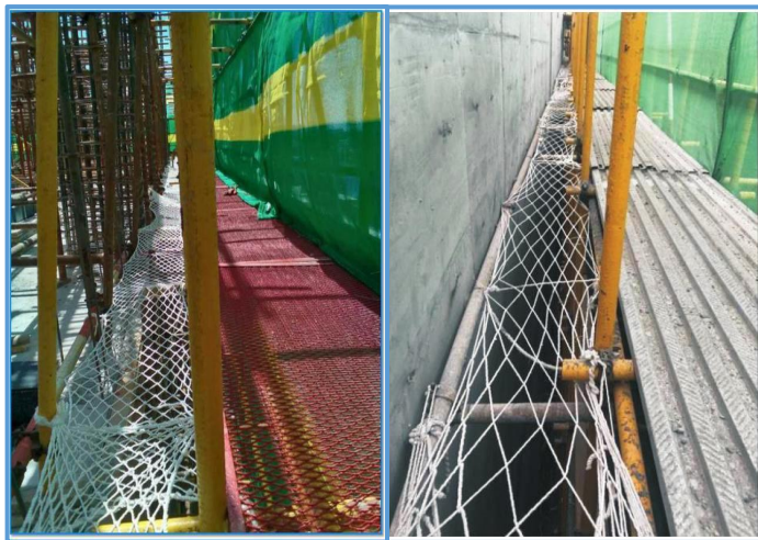
图3-8 脚手架与主体结构水平防护（2）
