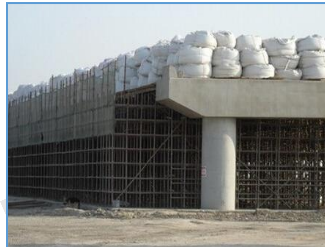
图8-65 满堂支架预压试验（2）
