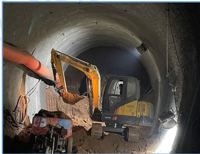
图8-111 隧道机械化施工开挖作业
