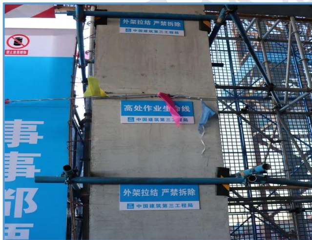
图3-3 连墙件设置（3）
