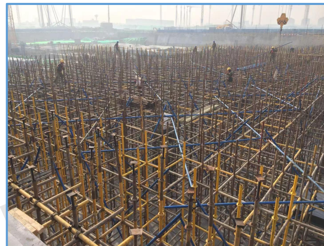
图4-12 扣件式钢管支撑剪刀撑设置（2）
