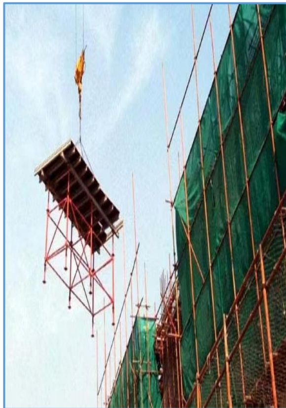
图4-21 飞模安装示意图（1）
