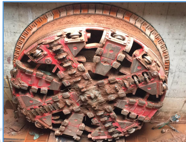
图8-139 盾构接收洞门
