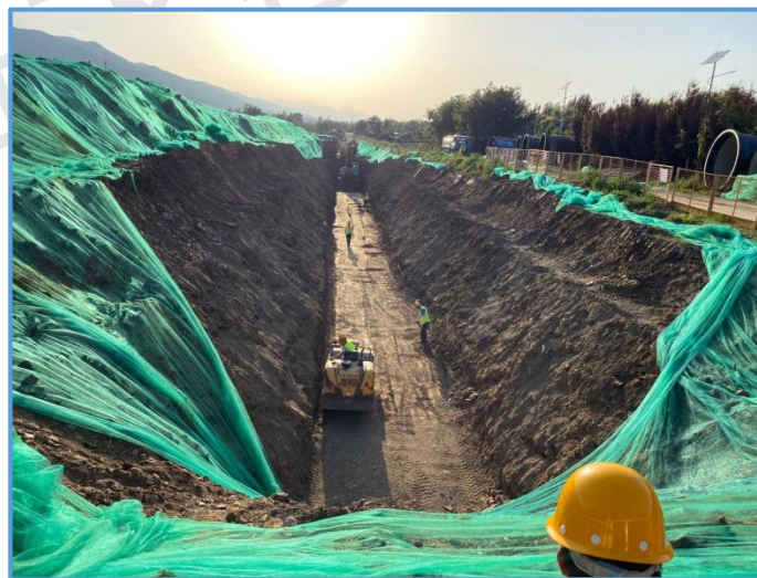
图8-24 沟槽回填(2)
