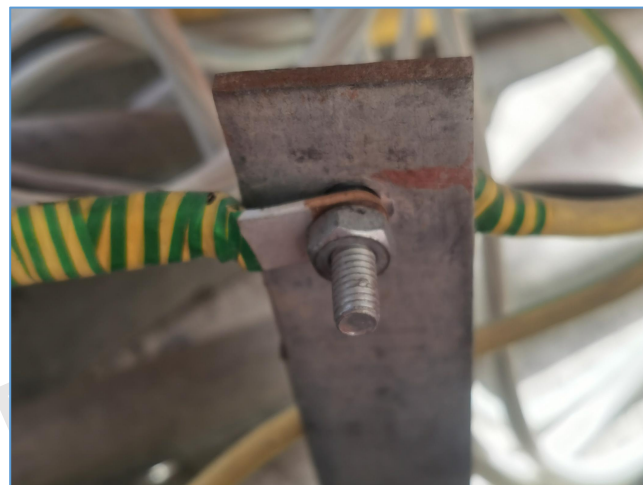
图5-32 接地端子螺栓、铜鼻
