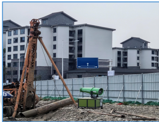
图6-192 桩机支腿支设
