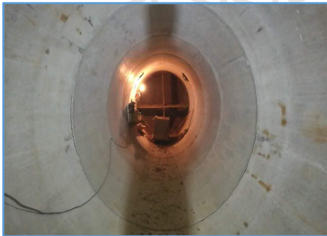
图8-33 顶管顶进方法（手掘式）
