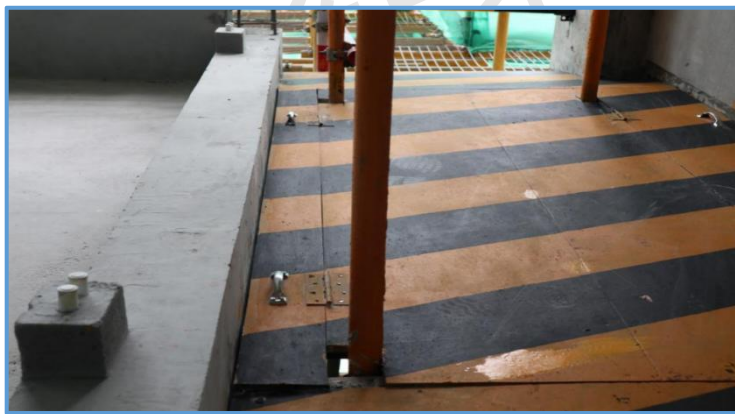
图3-8 脚手架与主体结构水平防护（3）
