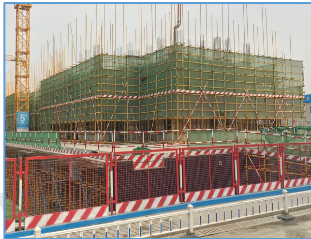
图3-10 脚手架外立面防护（2）
