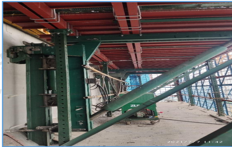
图4-20 爬模支撑示意图（2）
