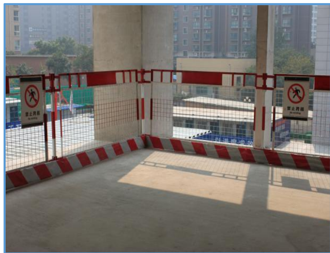
图7-41 楼层临边防护（2）
