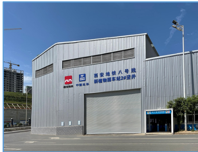
图8-75 全封闭厂棚实景图（白天）
