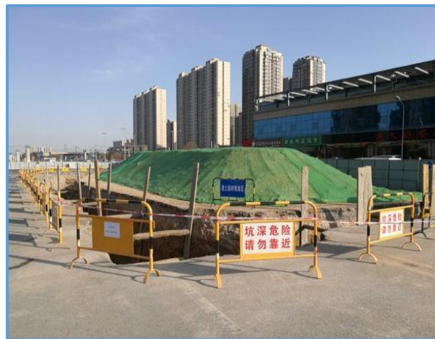
图8-19 沟槽临边防护及堆土
