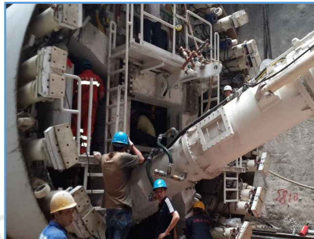
图8-149 螺旋机安装
