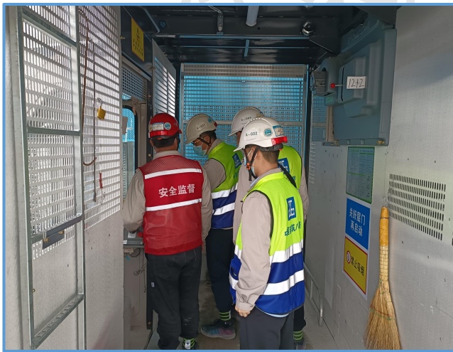
图6-71 施工升降机验收过程
