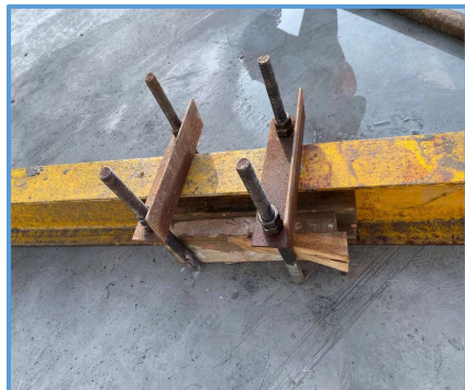
图3-12 预埋环压板安装
