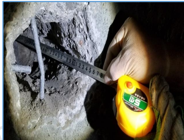
图8-113 超前地质探孔量测
