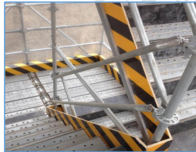
图2-31 基坑通道爬梯扶手（1）
