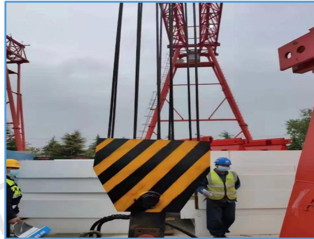
图6-163 龙门吊大钩安全警示色
