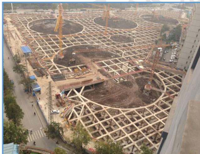
图2-7 基坑钢筋混凝土内撑支护（3）
