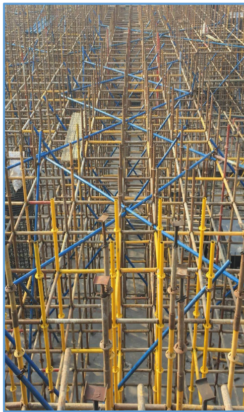
图4-17 承插型轮扣式支撑剪刀撑设置 (1)
