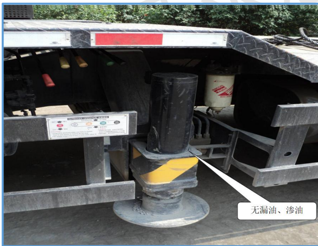
图6-124 汽车吊液压系统检查
