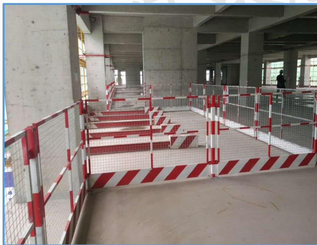
图7-41 楼层临边防护（1）
