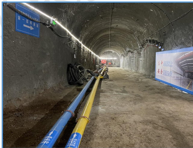
图8-99 横通道主风、水管布设
