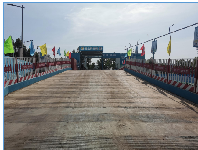
图2-29 基坑车行坡道
