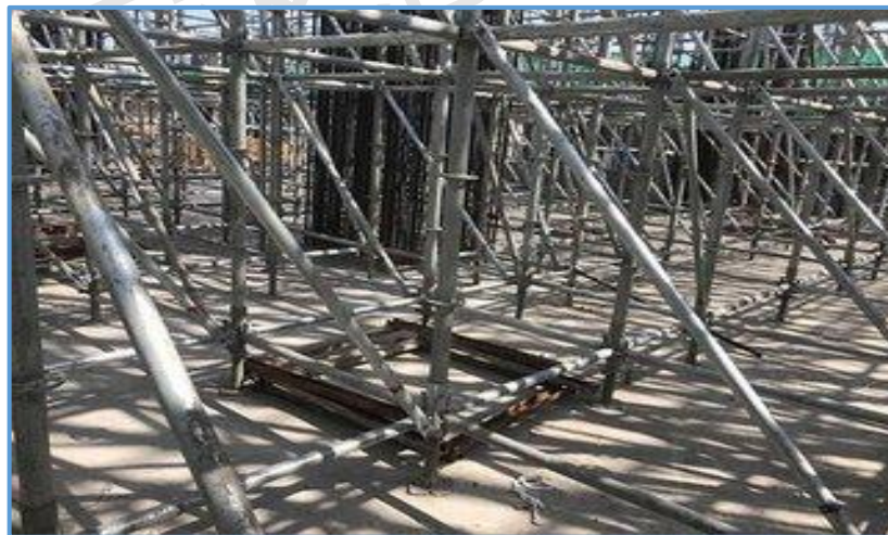
图4-6 承插型盘扣支撑架斜拉杆设置
