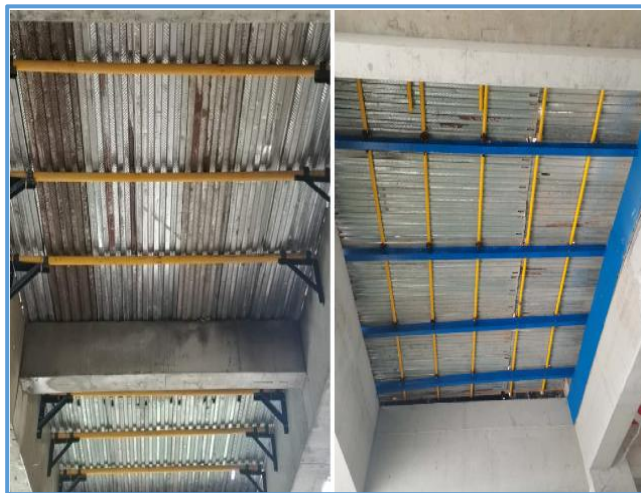
图7-29 电梯井洞口水平防护底部
