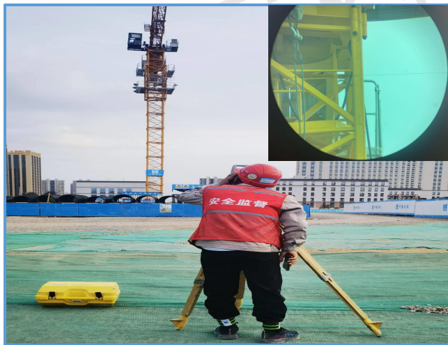
图6-39 塔吊垂直度测量
