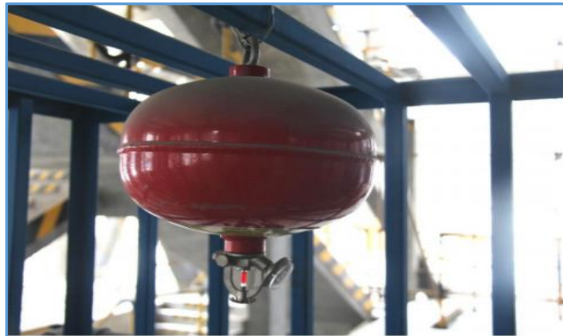
图9-73 感温自动灭火器（1）
