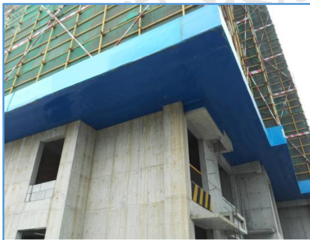
图3-17 脚手架架体封闭（1）
