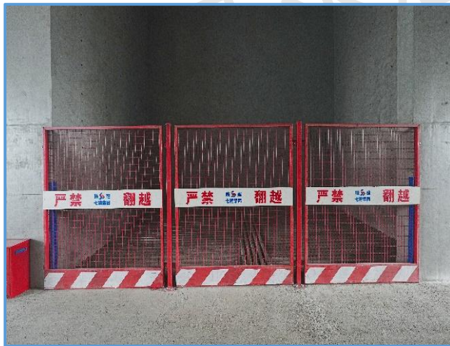
图7-31 电梯井洞口立面防护（1）
