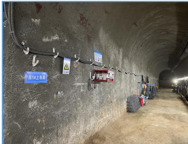
图8-94 隧道电缆敷设
