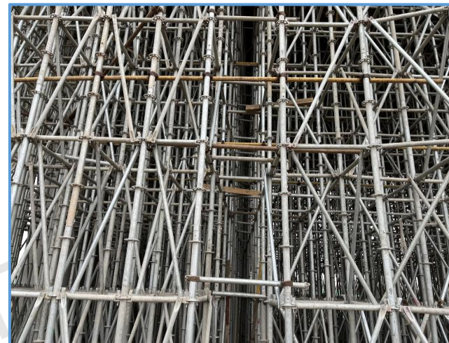
图8-61 支架分段搭设间连接
