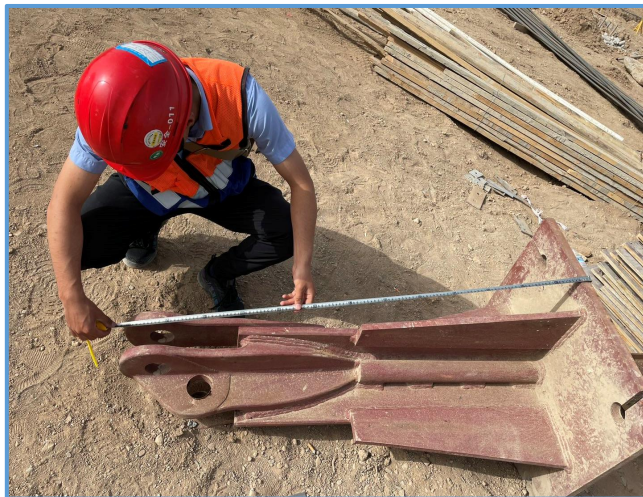
图6-5 塔吊基础预埋件
