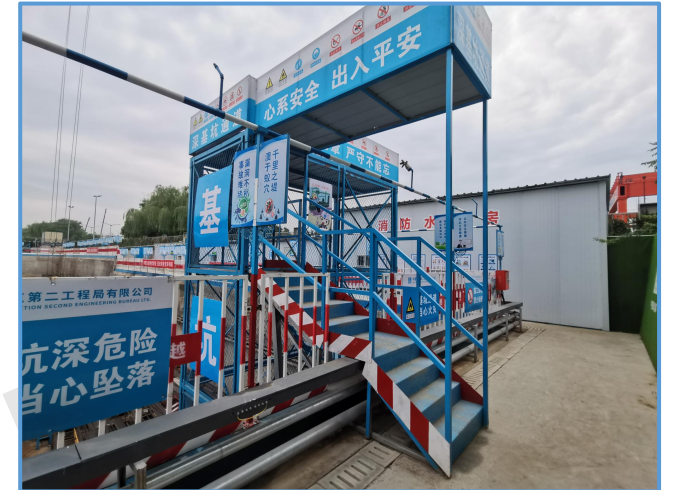
图2-30 基坑通道安全出口（2）
