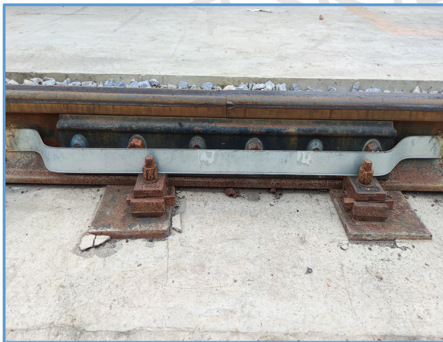
图6-168 龙门吊轨道接头
