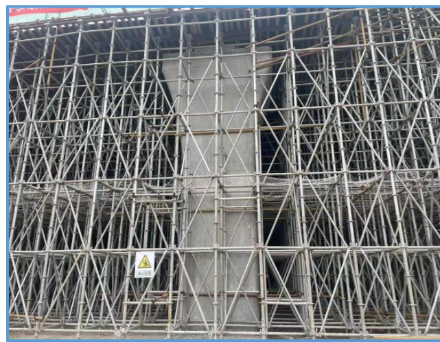
图8-59 支架与既有结构物可靠连接连接
