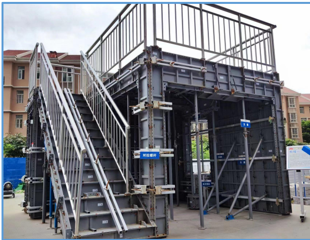
图4-19 铝模安拆示意图（1）
