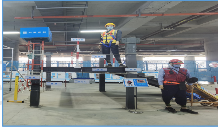
图7-76 钢结构安全防护样板
