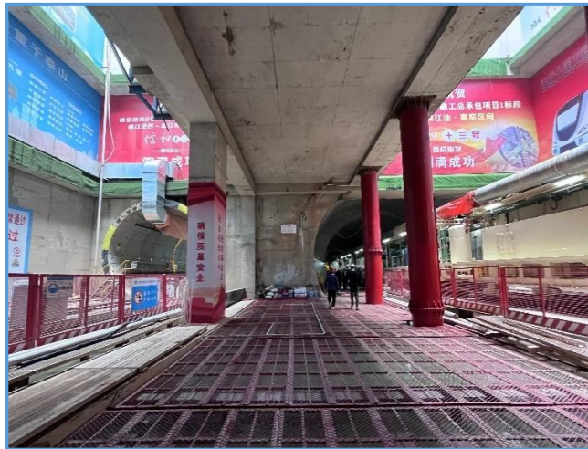
图8-129 洞外轨行区防护
