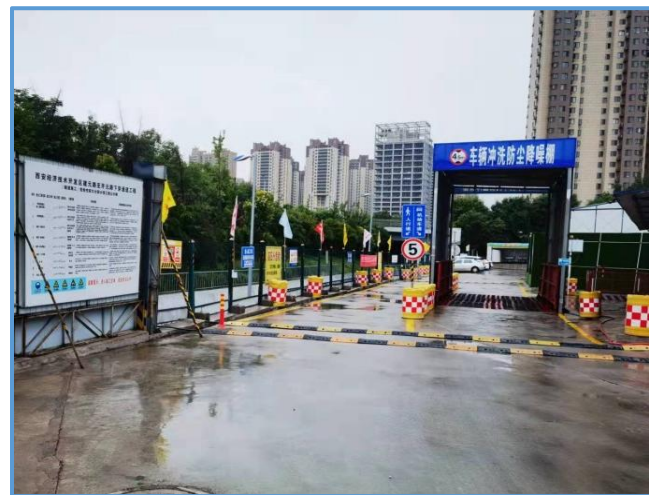
图8-11 车辆冲洗设施（2）
