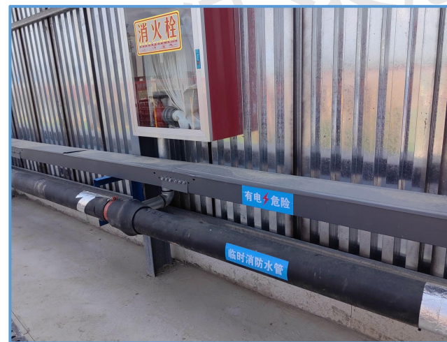
图5-14 定型化电缆桥架
