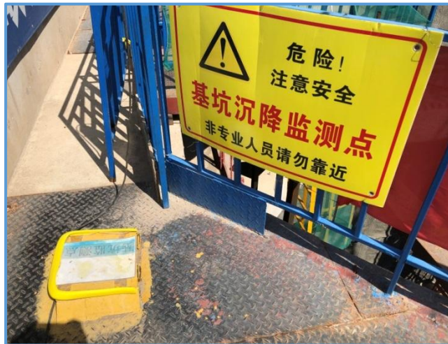
图8-31 基坑沉降监测点（1）
