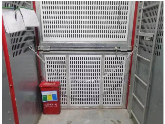
图6-96 施工升降机电梯门阻前冲装置
