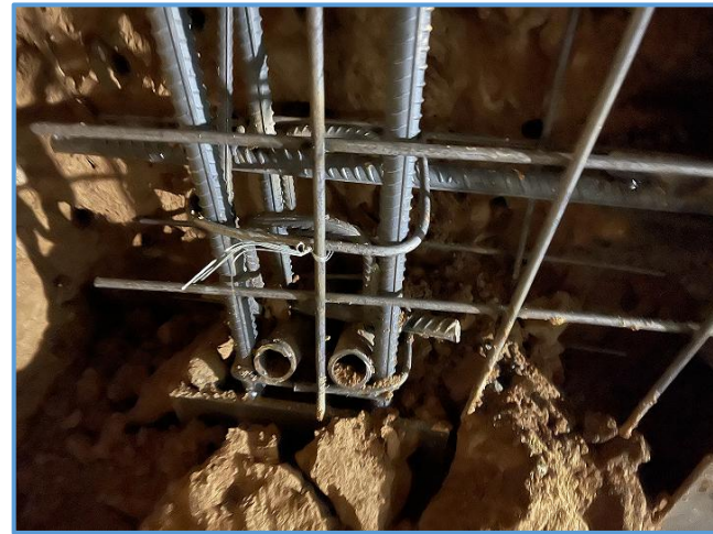
图8-115 锁脚锚杆打设
