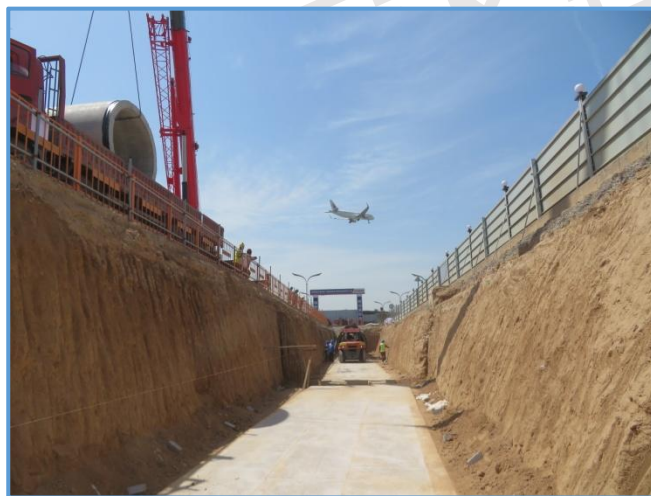
图8-20 沟槽临边防护
