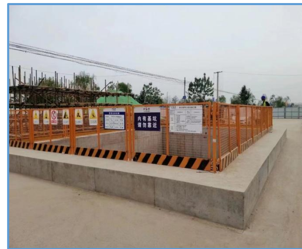
图8-27 顶管基坑围护(2)
