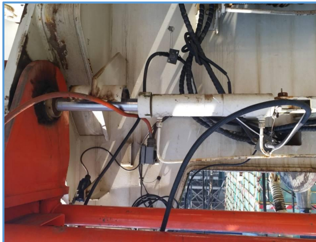
图6-138 履带吊油缸拆卸防脱卡安装牢固
