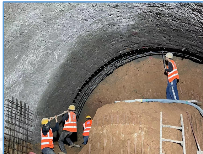
图8-110 暗挖隧道开挖支护
