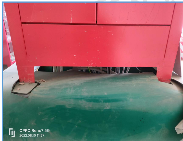
图5-10 设置绝缘垫
