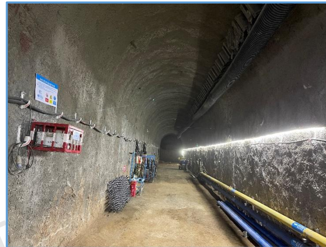
图8-95 隧道LED灯带照明
