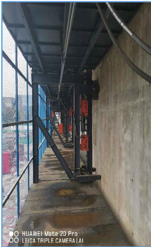
图4-20 爬模支撑示意图（1）
