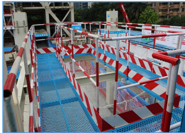
图7-77 钢结构施工安全通道
