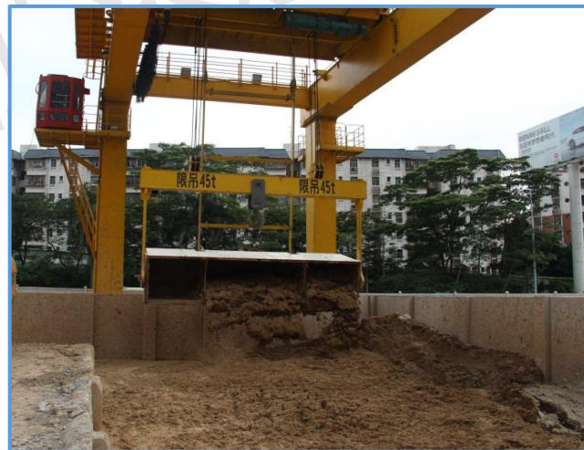
图8-153 45t龙门吊渣土翻倒
