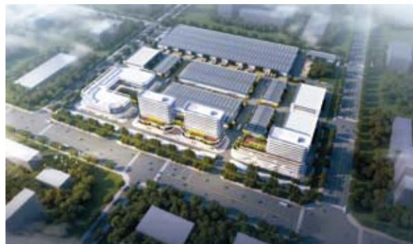
民机与航空制造产业园项目总建筑面积为152482.90m<sup>2</sup>，其中地上建筑面积为141055.32m<sup>2</sup>，地下建筑面积11427.58m<sup>2</sup>。由1#研发中心、2#孵化中心、3#检测中心，地上10层地下1层；4#、5#、8#、12#多层厂房，地上3层；6#厂房、7#、9#、10#，11#、13#单层厂房组成。项目位于西安航空基地，蓝天路以南、航空五路以西、航空六路以东。
