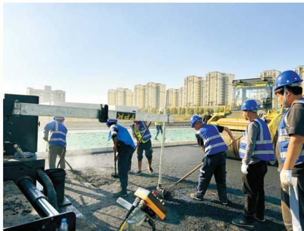
在阎良航空基地道路工程施工二标段项目规划五号路施工现场，随着最后一段沥青铺设完毕，一条笔直、宽阔、崭新的路面呈现在眼前，标志着规划五号路机动车道全线贯通，圆满完成通车目标。该项目位于西安市阎良区，5号路规划红线宽度30m，总长1035.76m，本次沥青铺设面积共计14490平方。沥青铺设前，项目部紧盯节点不放松，开启施工“加速度”，提前谋划、积极统筹调度，合理调配人、材、
