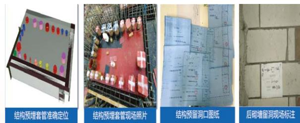
图6 精确预留孔洞位置
