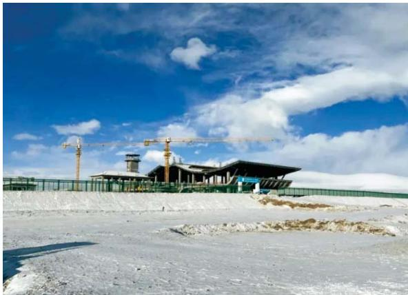
巴音布鲁克草原具有气压低、含氧量低的环境特点，项目面临机械设备工效损耗、施工技术复杂等难题。为降低环境影响，针对当地特殊的气候条件，项目团队因地制宜，优化施工方案。施工团队在现场布设温控设备，实时监测施工现场温度，当温度低于5℃时，技术人员便在混凝土中添加防冻剂，混凝土浇筑完成后，及时在表面覆盖保温棉毡及彩条布，通过蓄热法进行保温养护保证混凝土质量。
