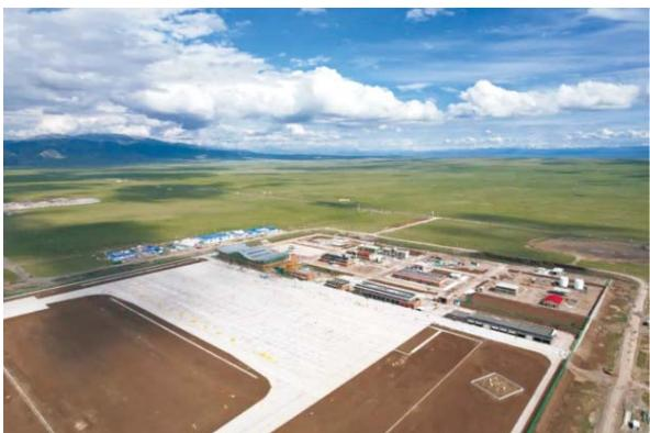
从2022年5月16日打下第一根桩，到5月23日插入主体结构施工，项目团队90天实现23个单体混凝土结构封顶任务，120天完成航站楼钢结构及室外管网施工。项目近500名项目建设者克服高原恶劣自然条件，坚守岗位、攻坚克难，安全有序推进工程进度。
