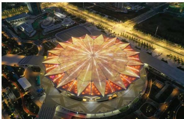
从空中俯瞰体育馆，顶部的16个角伸向空中，造型如飞檐，又有宫殿之势，外立面造型硬朗、棱角分明、舒展绽放。从远处望去，体育馆犹如一颗璀璨的巨型钻石，光彩夺目、气势恢宏。外立面采用铝板幕墙、窗花幕墙两种不同材质，三角幕墙虚实结合，增加建筑的灵性与柔美，又实现了内部采光需求。整个
