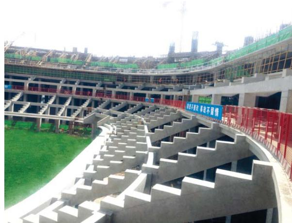
域首次引用预制清水看台板，先后克服了U型板加工、脱模剂使用弧形结构等多个技术难题，完成看台板3010块，总重约为4500吨。施工图纸构件型号类型高达500余种，每块间的拼缝严格控制在2公分，看台板清水般的自然质感与观众实现了零距离接触。
