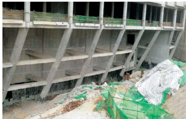
图6 17个超大斜柱施工
