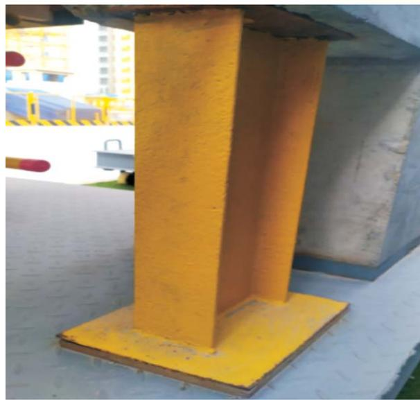
图2 工字钢回顶样板
