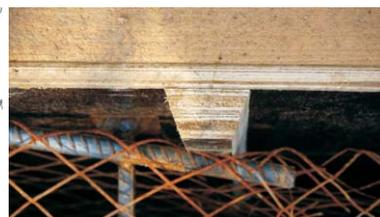
图2 竖向温度凹槽图
