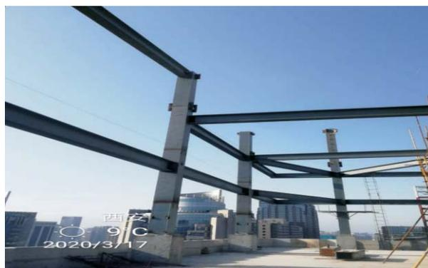
图13 400吨钢结构屋面安装
