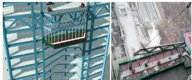
图22 瀑布幕墙钢结构吊挂体系
