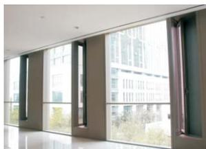
图27 侧开式腔体构造
