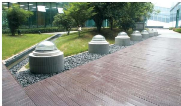
图28 导光管采光系统
