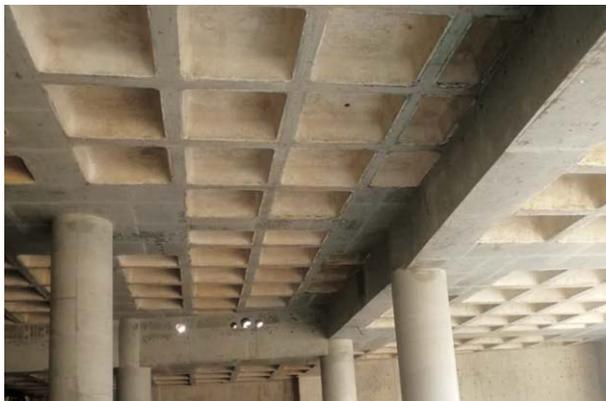
图3 4.1万平方米PK模板安装
