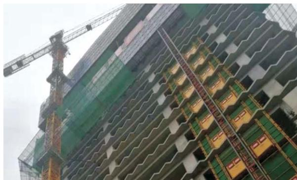
图12 4300米锯齿节点板施工
