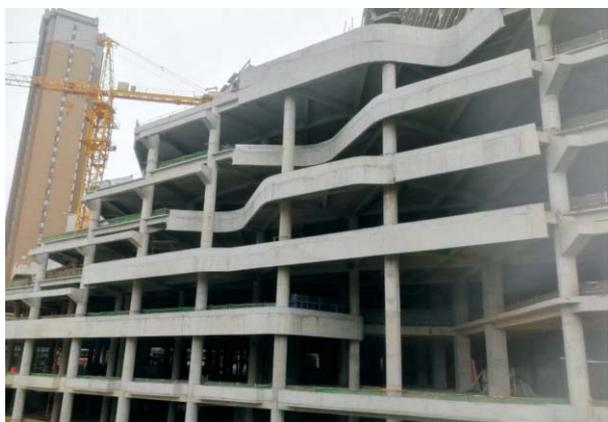
图9 裙楼外形圆弧曲面错落布置
