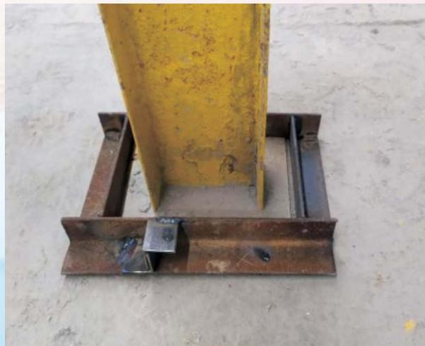
图4 工字钢底部灌浆模具
