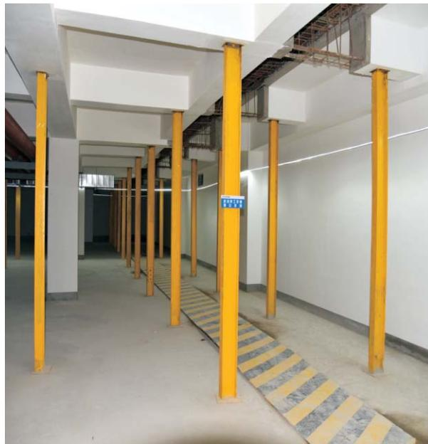
图3 工字钢回顶效果
