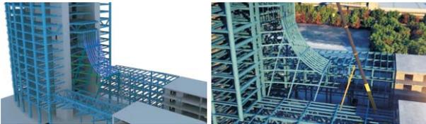
图32 门式刚架安装施工模拟
