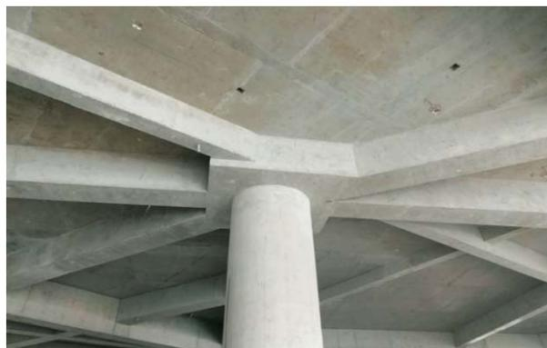
图11 多梁交汇处方柱帽施工
