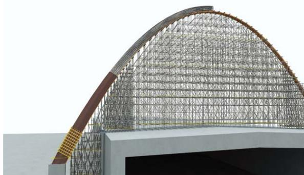
图9 延安全民健身中心大跨度混凝土圆拱模型
