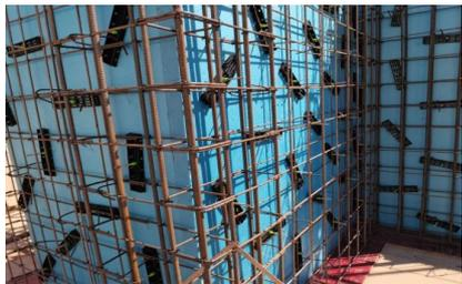
保温板与主体结构钢筋连接
