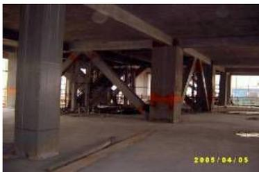
钢框架—中心支撑结构
