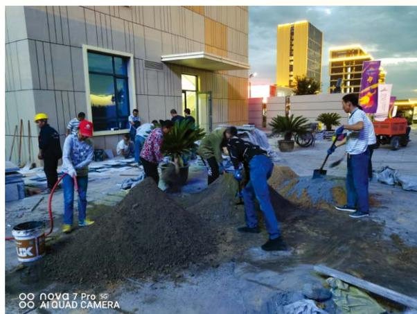
九建维保服务队成员不诉苦、不言难，立即组织60名劳务工人展开抢修。时间紧、任务重，12小时的连轴转，劳务工人队伍被分为5个小组，有的使用大功率电镐破除地面混凝土垫层；有的使用三轮车清理混
