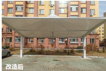
电动自行车充电棚建设前后
