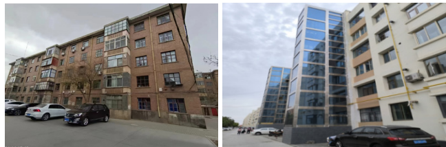
老旧楼栋改造及加装电梯前后对比
