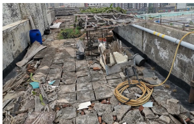
水仙花园老旧小区市政管网改造
