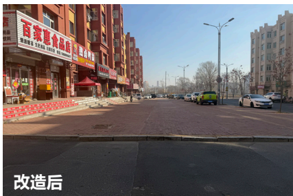
破损道路修复前后
