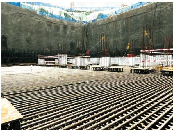
据悉，本次浇筑区域为该项目核心区域——歌剧院筒仓筏板，基坑深度达-37.5米，筏板面积1732平方米，厚度为2.5米（最深区域达5.15米），筏板钢筋用量超过1700吨，含102块舞台机械预埋件，整体以型钢支架为支撑，施工场地极其狭窄，充分体现了项目“难、大、精、深”的特点。
