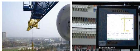
应用塔吊防碰撞、吊钩可视化等系统，动态监控群塔作业情况，解决施工现场塔吊司机视觉死角、远距离视线模糊、语音引导易出错等行业难题。情绪识别、安全教育、智能体检、WIFI安全教育等系统，可随时关注工友情绪变化，及时进行心理疏导，同时通过VR安全体验+安全教育视频相结合的宣传方式，累计教育1713人次。
