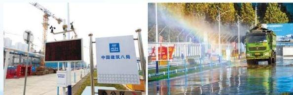
项目采用环境监测、自动喷淋以及水电监测系统，通过传感器进行温湿度、PM2.5等数据采集，数据直接上传环境主管部门后台系统，为扬尘防控提供技术
