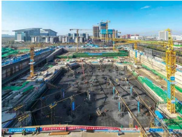
图3 塔楼筏板大体积混凝土浇筑盛况
