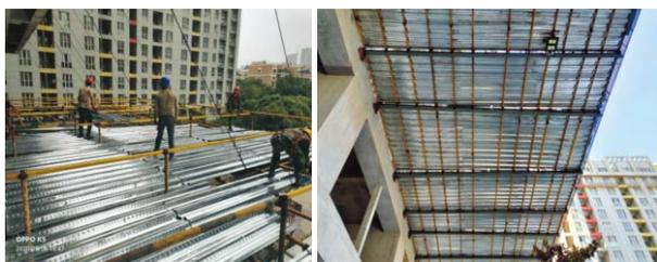
图3.3.8-2 铺设底层压型钢板
