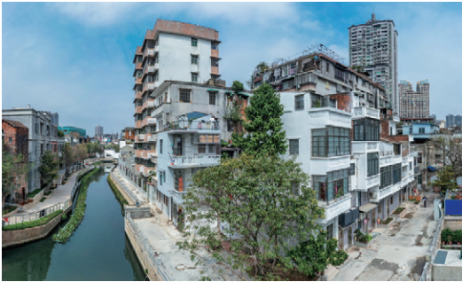
图8 居民房屋立面修缮与门窗更换
