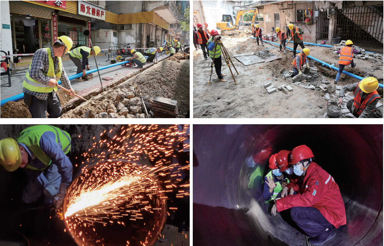
图7 管道施工实景
