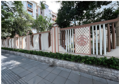
图4 改造提升小区外墙
