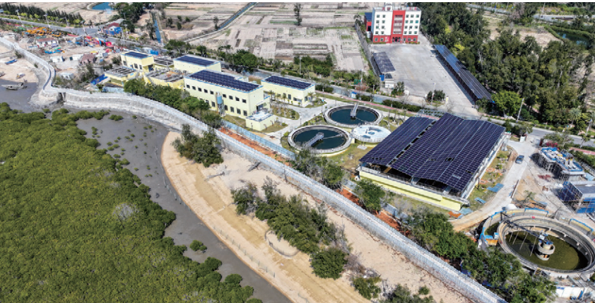
图5 绿色低碳改造后的中水处理站微电网
