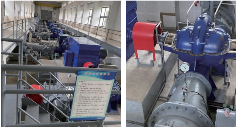
图5 改造优化水厂泵房
