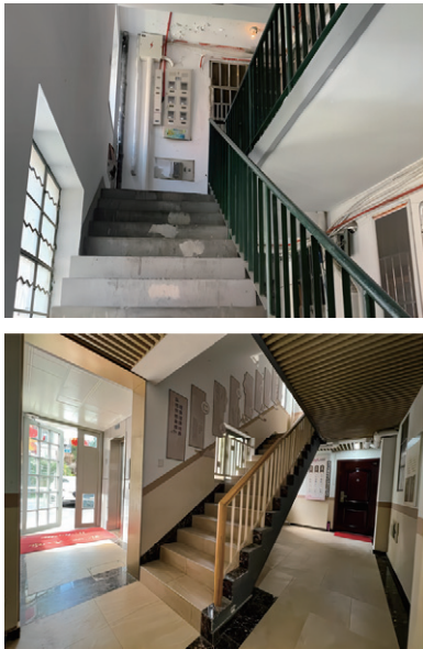
图6 房屋室内楼道改造前后对比
