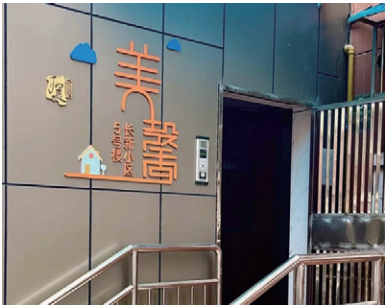
图4 电梯加装与“美馨楼道”改造后实景
