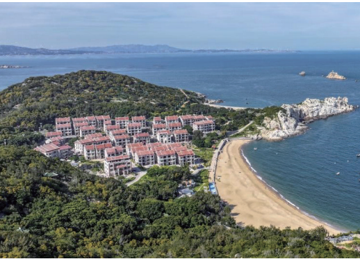
图3 湄洲岛民宿改造后实景
