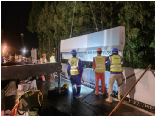
图4 内环高架防撞墙吊装现场
