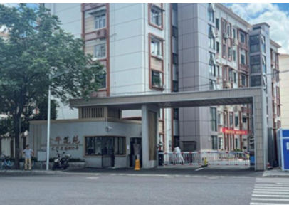
图3 加装电梯、改造提升小区大门
