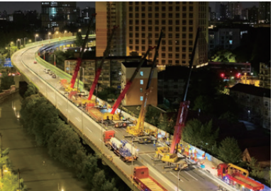
图7 夜间封道后施工作业
