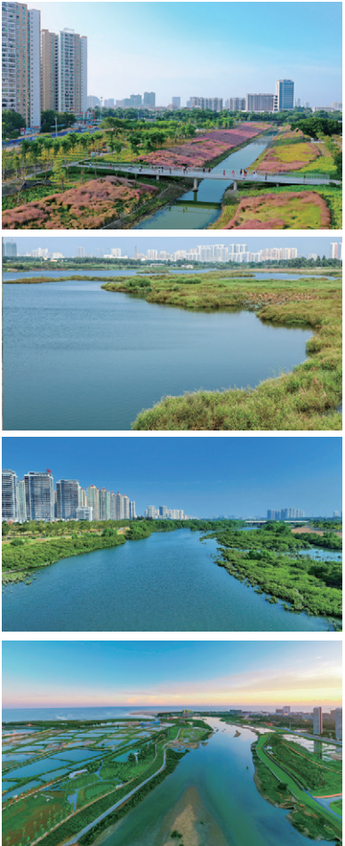
图3 渠、库、江、滩治理后实景
