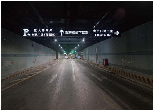
图4 地下人防工程改扩建后实景
