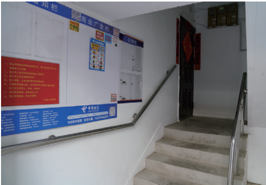
图9 楼栋内无障碍改造后实景
