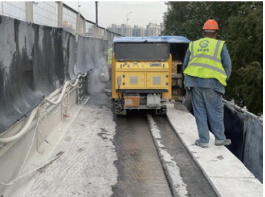
图8 小型化、低噪声水射流机器人应用
