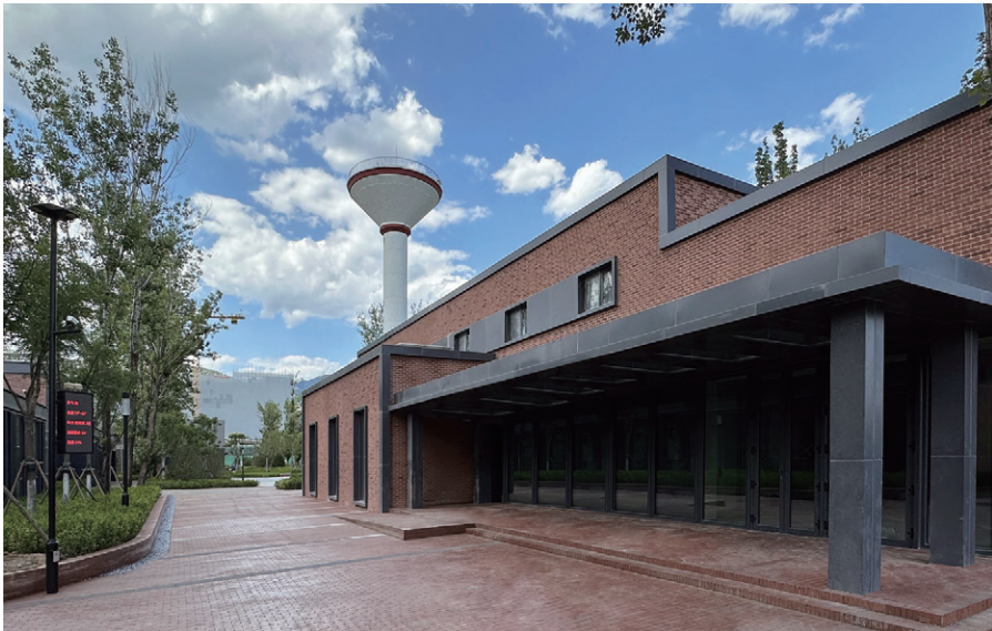
图8 原水泥厂锅炉房改造为零碳建筑
