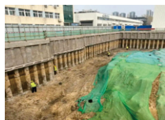
支护结构变形
