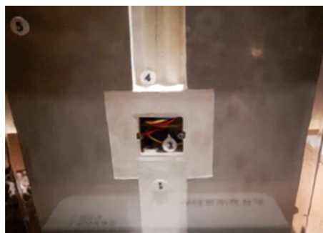
线盒封堵工序样板图
