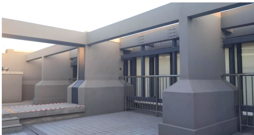
出屋面构建被动区延伸节点图
