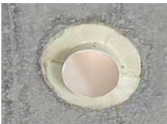
管道聚氨酯发泡保温封堵
