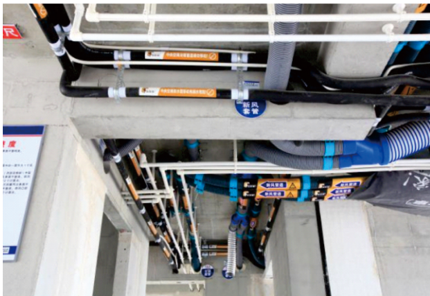
多联机系统安装工序样板图
