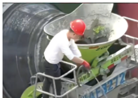
混凝土泌水、离析，施工时私自加水
