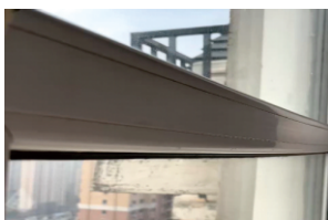
窗框型材弯曲变形 入户门关闭不严
