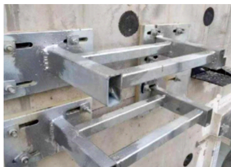
埋板断热桥处理完成效果
