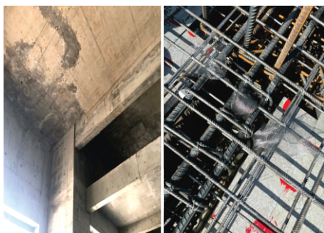
梁柱核心区混浇
