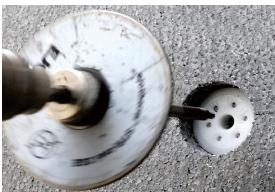
断热桥锚栓沉入式打法
