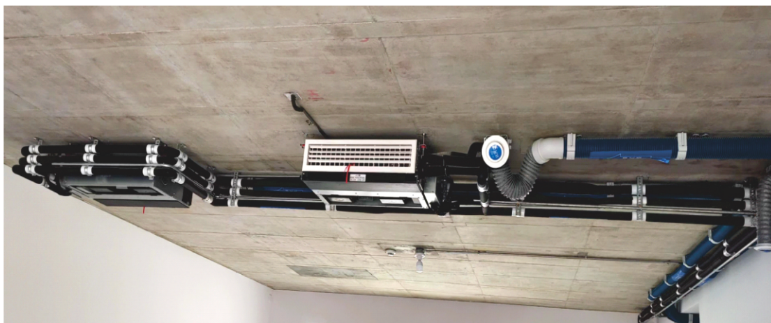
新风空调管路安装
