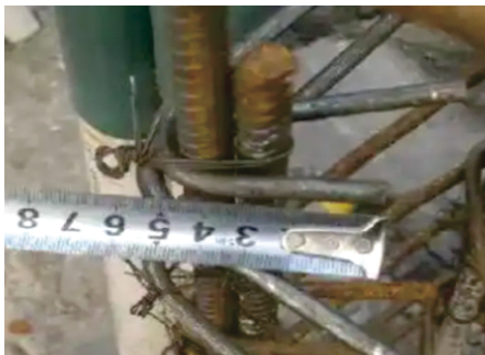
箍筋弯钩长度、弯折角度不规范
