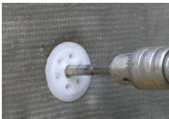
断热桥锚栓浮头式打法
